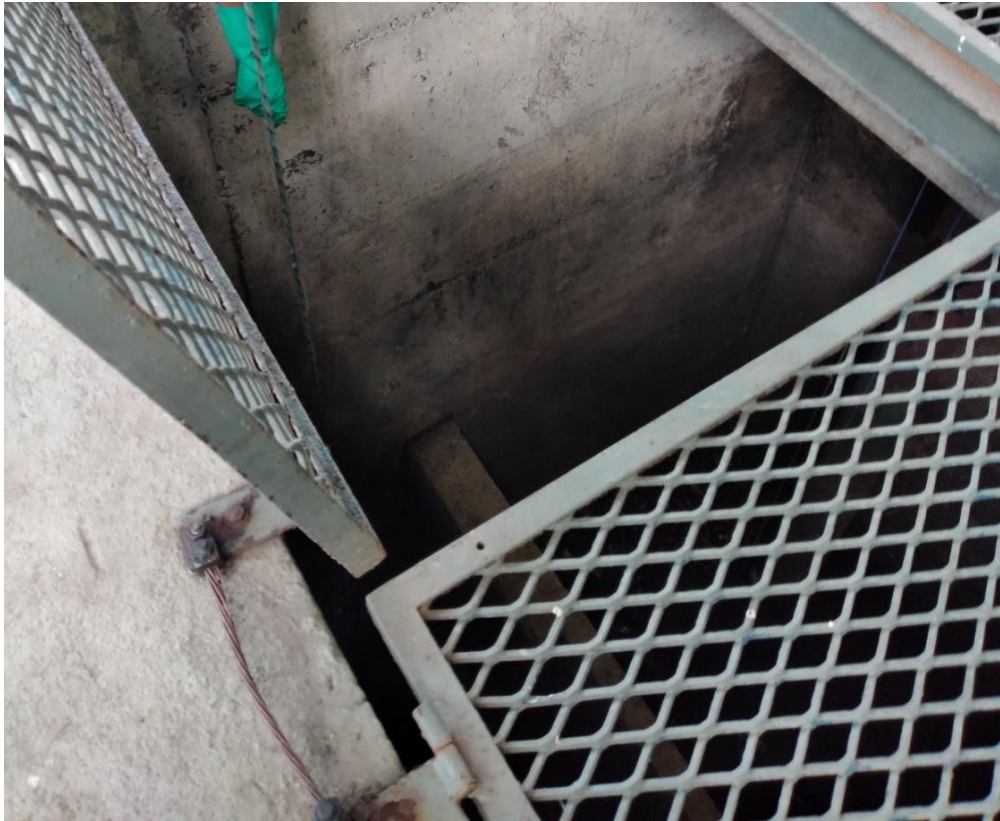
Figura 5 – Coleta realizada em esgoto bruto da ETE Central.
