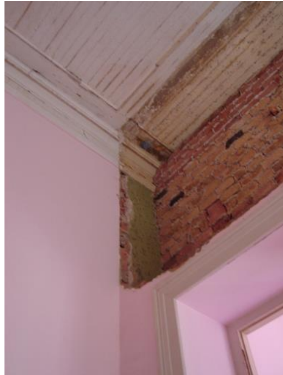
Figura 18: Demolições dos acréscimos da ala antiga – 1º. Pavimento Fonte: acervo DPH/COC (2006)
