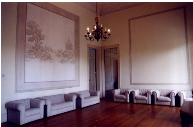
Figura 11: salão principal pavimento superior antes da restauração Fonte: acervo DPH/COC (2001)
