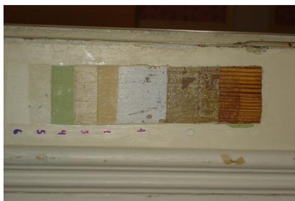
Figura 31: Prospecções pictóricas Fonte: DPH/COC (2007)
