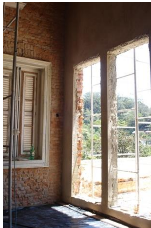
Figura 29: abertura de vãos para o terraço. Fonte: DPH/COC (2008)
