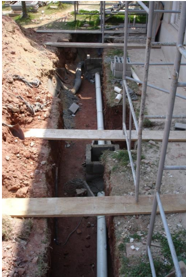
Figura 19: execução câmaras de ventilação para tratamento da umidade interna. Fonte: DPH/COC (2007)
