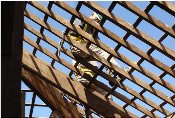
Figura 33: Remoção das telhas e lavagem
