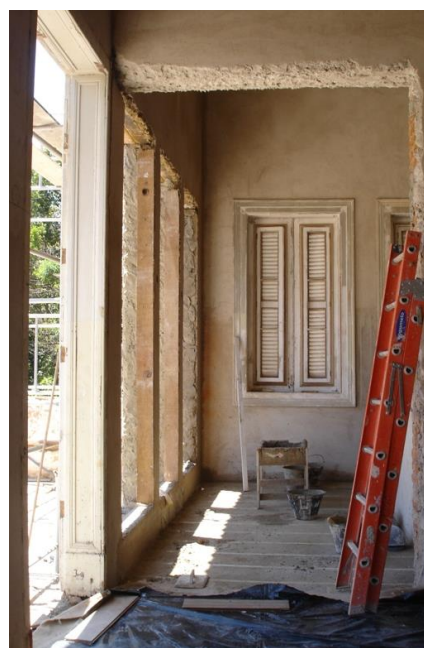
Figura 26: Abertura de vãos acesso terraço Fonte: acervo DPH/COC (2008)
