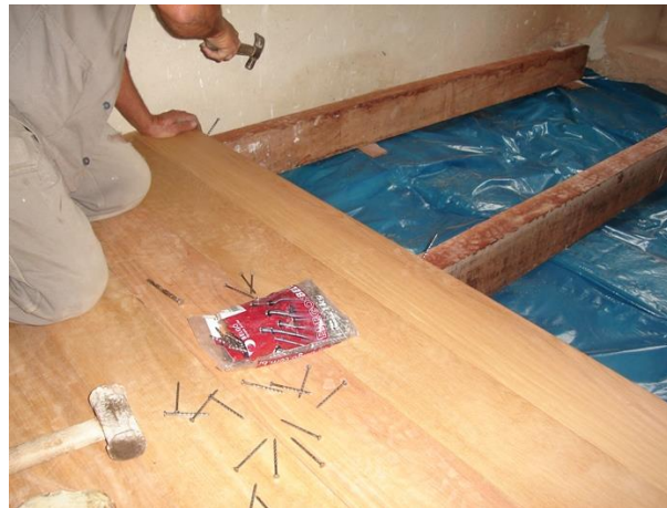
Figura 22: Finalização da galeria interna Fonte: DPH/COC (2007)
