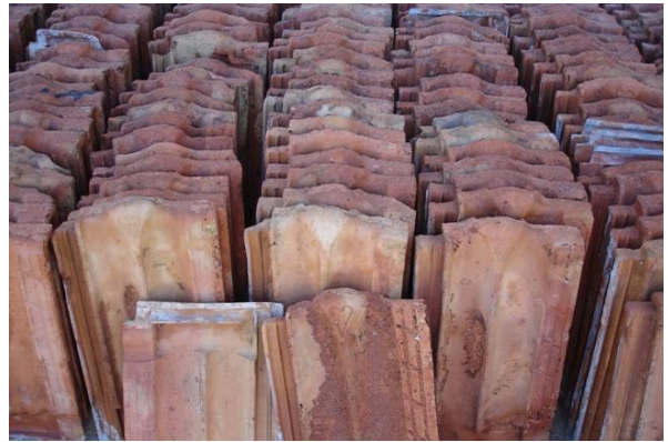
Figura 33: Remoção das telhas e lavagem
