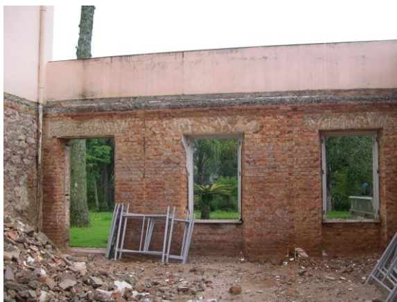
Figura 24: construção do auditório e terraço. Fonte: acervo DPH/COC (2007)
