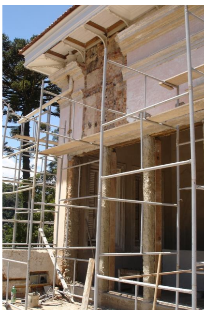
Figura 25: Abertura de vãos na fachada lateral Fonte: acervo DPH/COC (2008)
