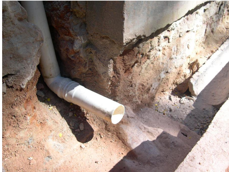
Figura 20: detalhe tubo para ventilação interna Fonte: DPH/COC (2007)
