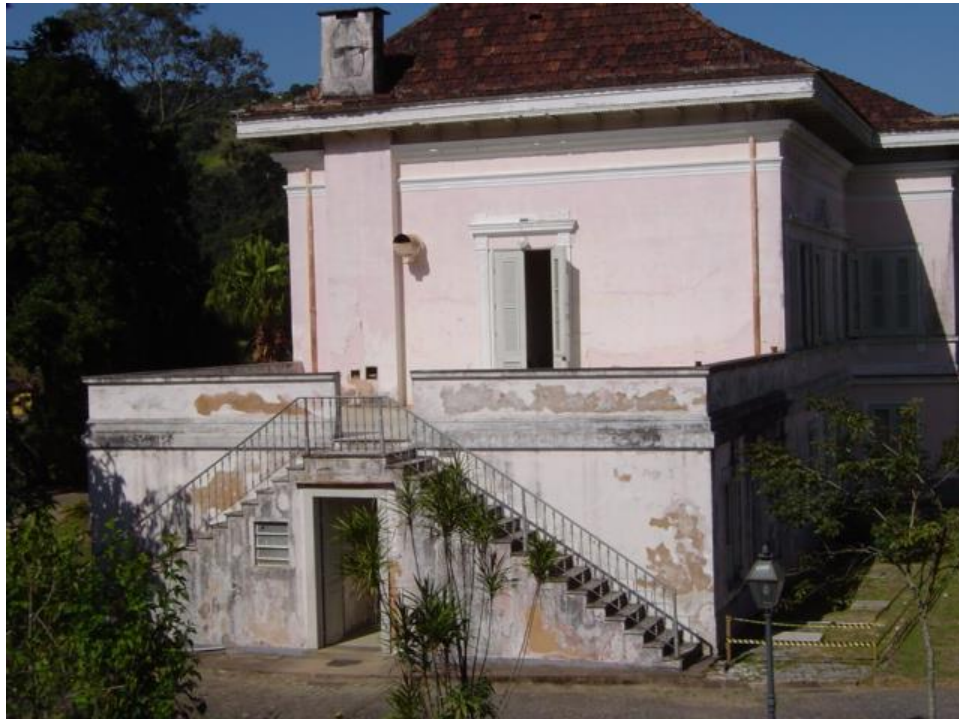
Figura 10: Fachada lateral – noroeste: nota-se em primeiro plano o volume acrescido na década de 1940 para abrigar a cozinha e dependências de serviço. Foi construída uma escada para acesso ao terraço e uma chaminé para a coifa do fogão. Fonte: acervo DPH/COC (2001)
