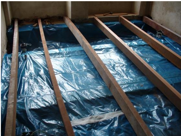
Figura 21: galeria interna de tratamento da umidade Fonte: DPH/COC (2007)
