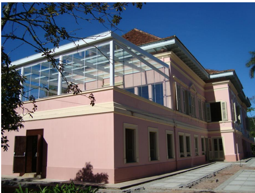
Figura 30: Cobertura do terraço. Fonte: DPH/COC (2010)
