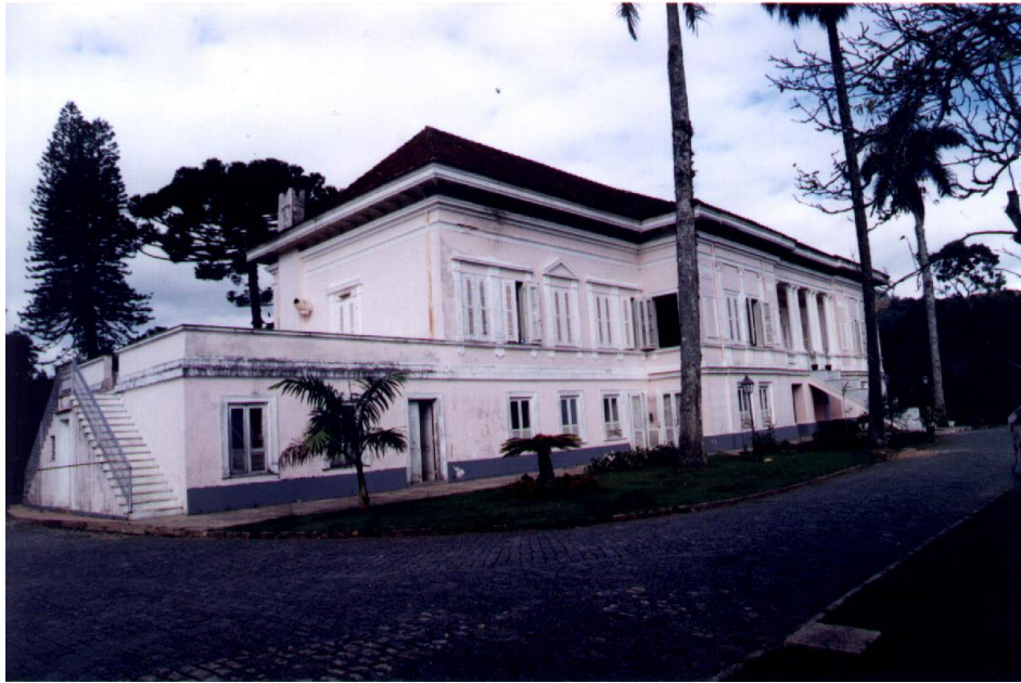
Figura 8: Fachada frontal: nota-se, no lado esquerdo da foto, o volume construído na década de 1940. Fonte: acervo DPH/COC (2001)
