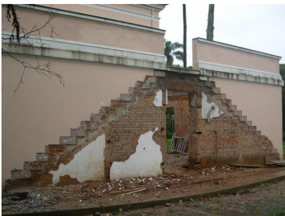
Figura 23: Demolições na escada externa. Fonte: acervo DPH/COC (2007)
