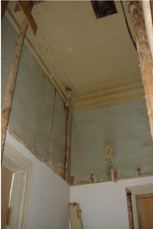
Figura 17: Demolições dos acréscimos da ala antiga – 1º. Pavimento Fonte: acervo DPH/COC (2006)
