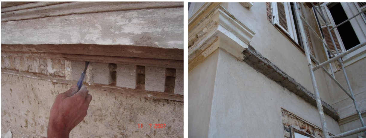
Figura 32: Recuperação dos ornamentos da fachada Fonte: DPH/COC (2007)
