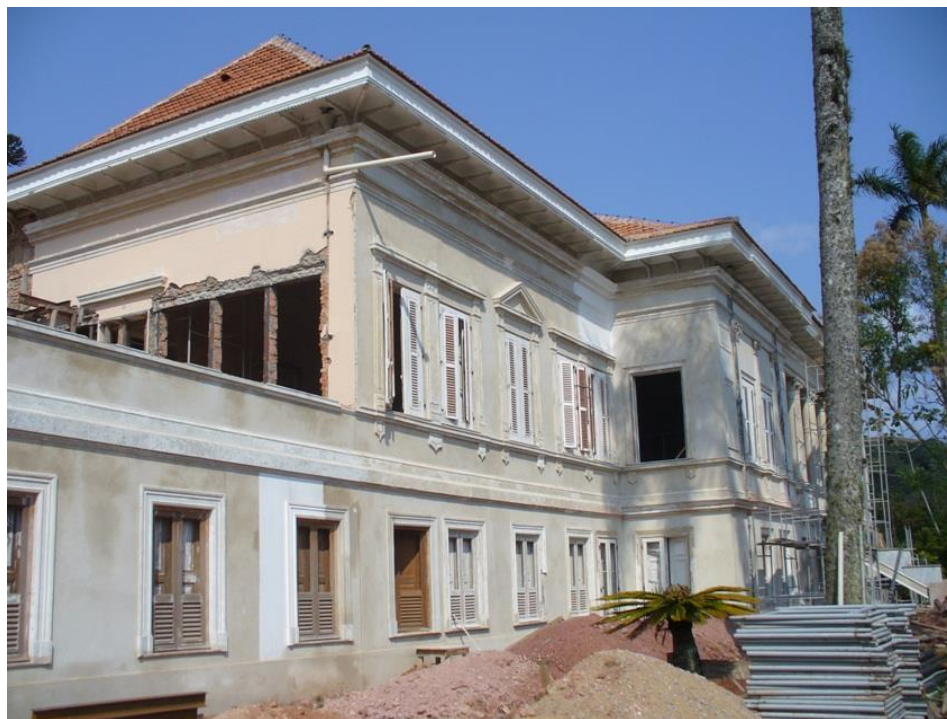
Figura 27: Abertura de vãos na parede da fachada lateral Fonte: acervo DPH/COC (2008)
