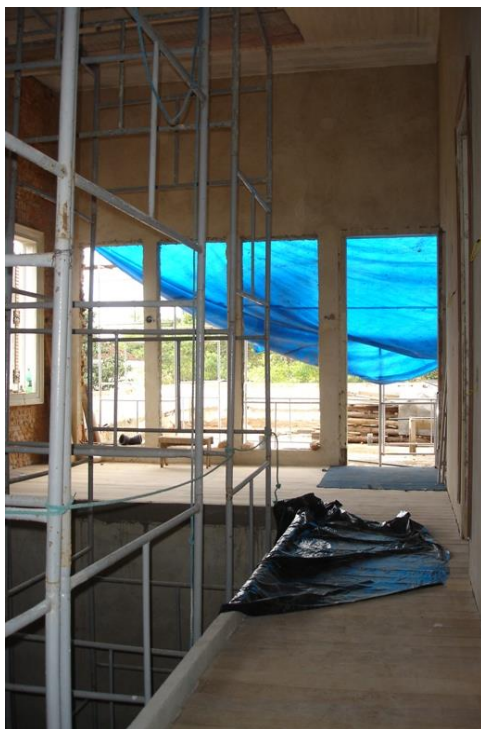
Figura 28: demolição de trecho da laje para execução da circulação vertical. Fonte: DPH/COC (2008)
