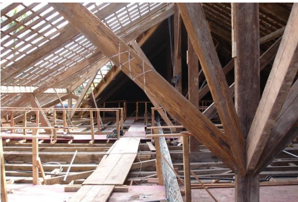
Figura 34: Telhado limpo em fase de inspeção e troca de madeiramento
