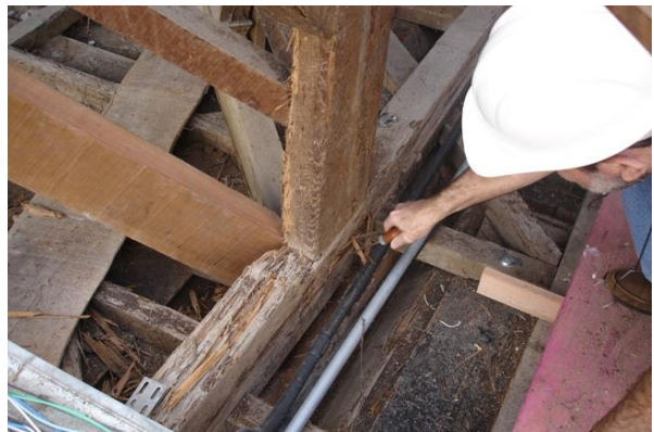
Figura 34: Telhado limpo em fase de inspeção e troca de madeiramento
