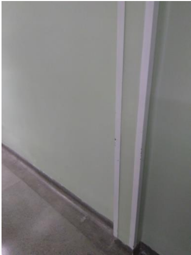
Figura 2. Proteção de canto de parede.
