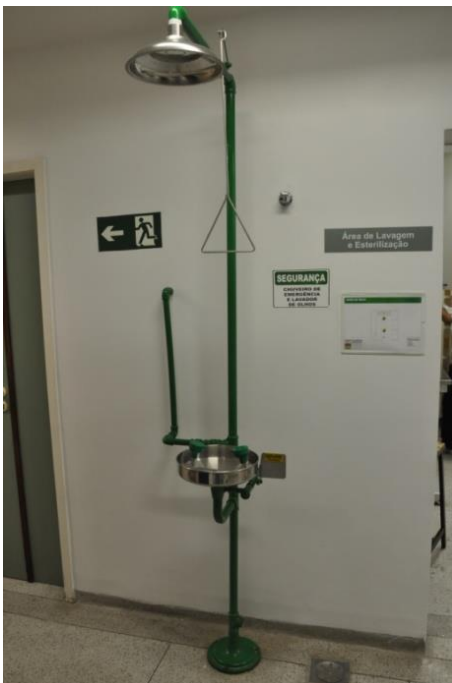
Figura 18. Lava-olhos acoplado a chuveiro de emergência.
