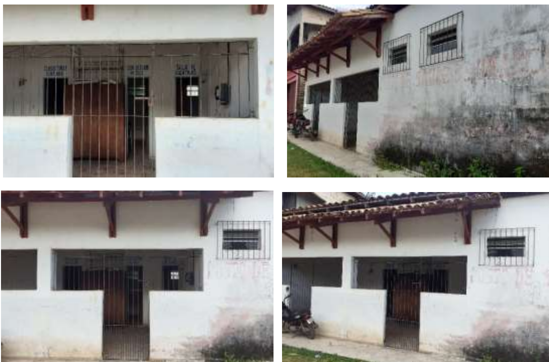
Figura 29 – Fotografia do primeiro posto de saúde instalado em Umarizal Beira.
