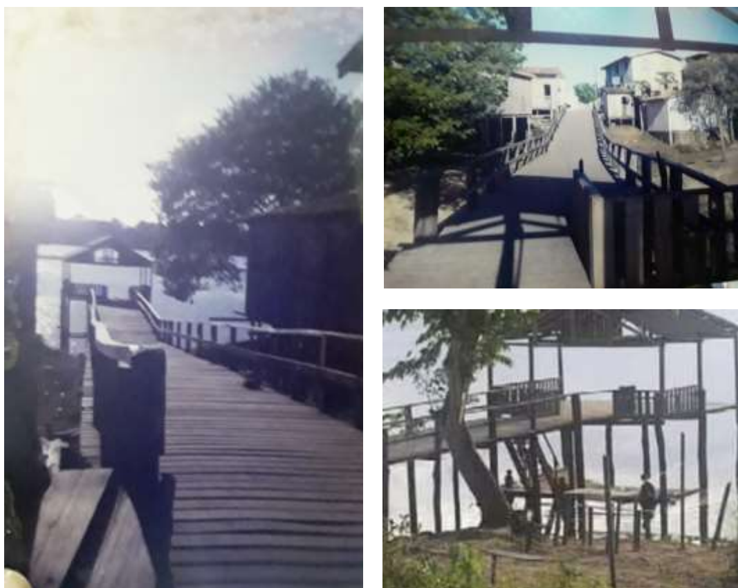
Figura 24 – Fotografia ilustrando o antigo trapiche da Vila de Umarizal Beira, construído ainda em madeira, até a década de 1970.
