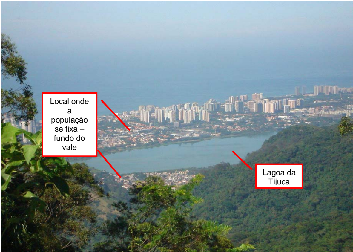
Fotografia 2: Visão holística da baixada de Jacarepaguá
