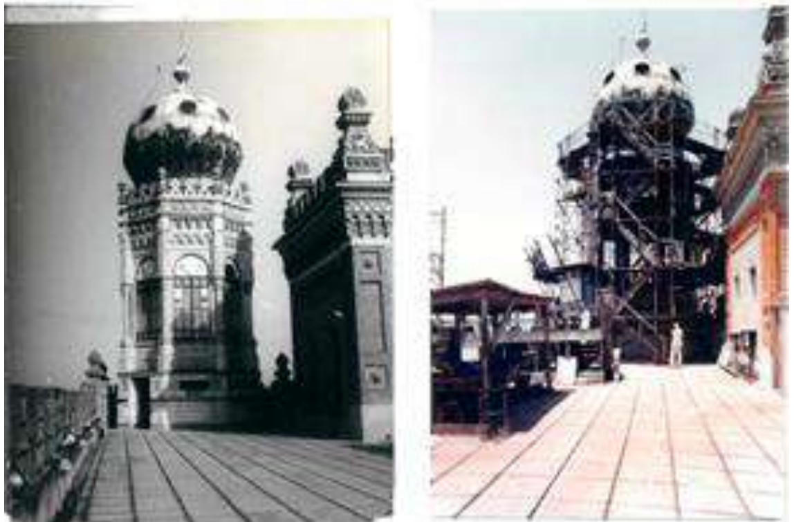
Figura 17: Da esquerda para a direita: Torre antes (ou depois) da intervenção de restauro; Torre durante a intervenção. Fonte: COORES/DPH/COC. ca, 1990.
