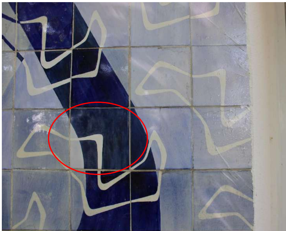
Figura 15. Exemplo de azulejo replicado para recomposição de painel. Fonte: Juliana Lopes, 2021.
