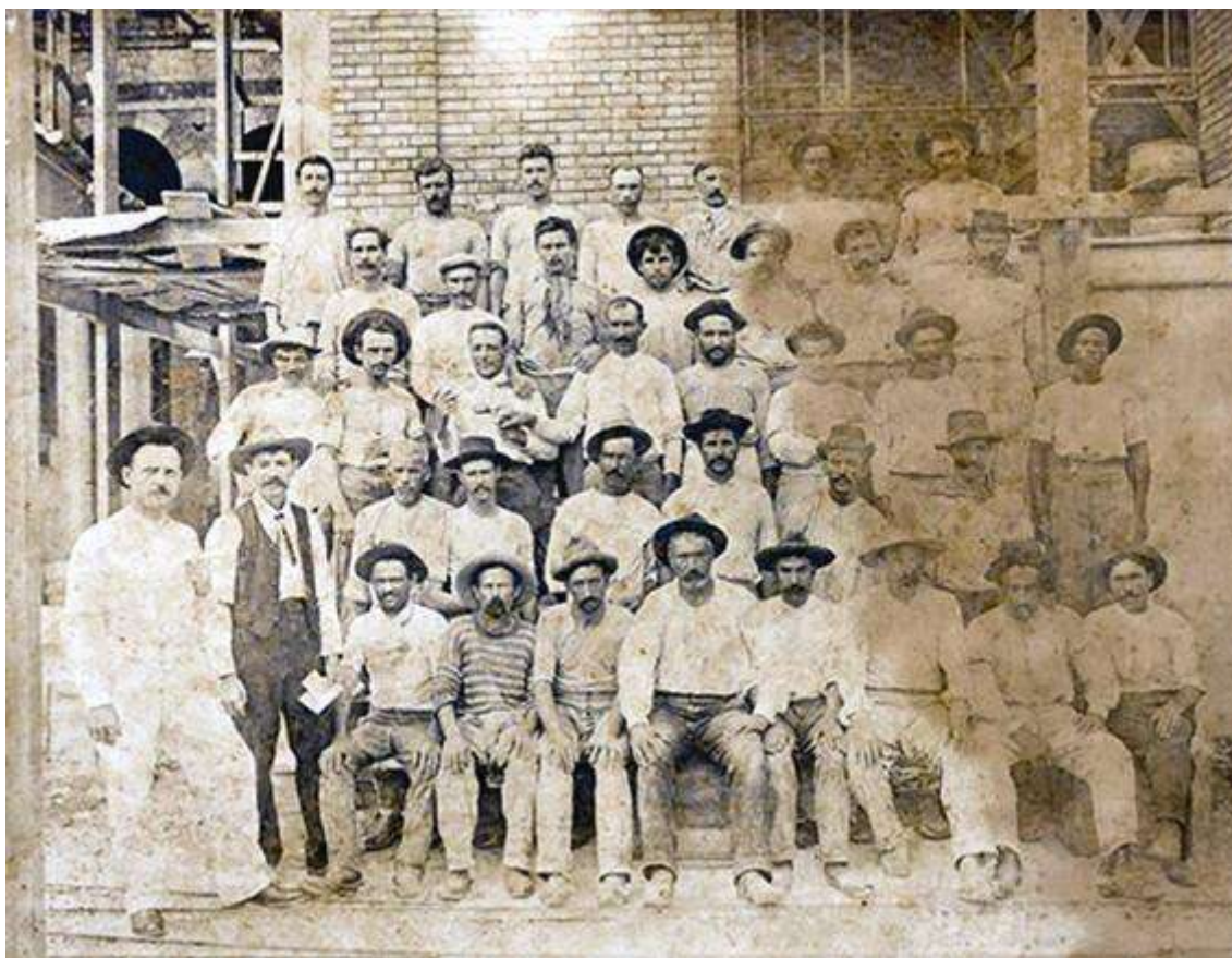
Figura 05: Operários que atuaram nas obras de construção do Pavilhão Mourisco. Fonte: Base Arch Fiocruz, Data ca. 1910.
