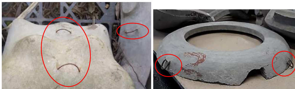
Figuras 44 e 45: Destaque de alças em metal oxidadas pela ação da umidade.
