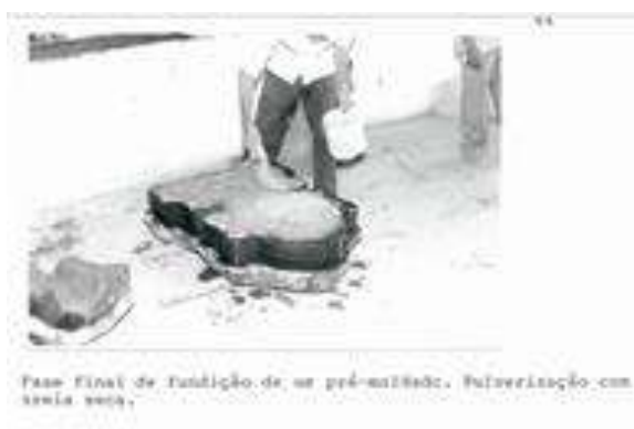
Figuras 12 e 13: Etapas finais da fundição do ornato 33; Exemplo de fôrma em argamassa de cimento e réplica fundida do ornato número 28. Fonte: COORES/FIOCRUZ, 1989.
