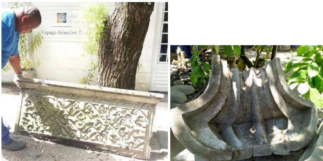
Figuras 21 e 22. Fôrma do relevo número 20 confeccionada em peça única; fôrma do ornato número 15 confeccionada por um berço e três tasselos. Fonte: DPH/COC, 2017.
