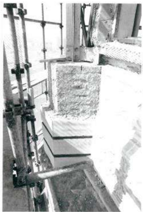
Base da coluna confeccionada "in loco", com estrutura em alvenaria de tijolo maciço com revestimento em argamassa no traço 1:4. (Fev/89)
