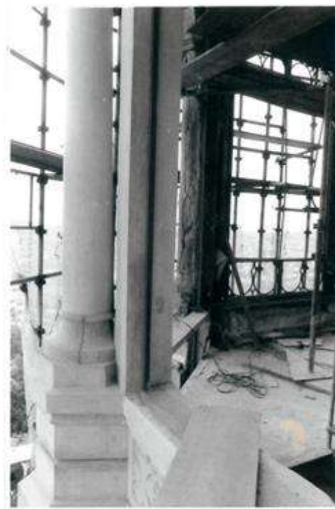
Pedestal, base e fuster da coluna já recompostos, sendo a peça nº 6 ( base) confeccionada "in loco".
