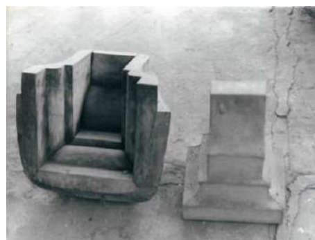
Figuras 12 e 13: Etapas finais da fundição do ornato 33; Exemplo de fôrma em argamassa de cimento e réplica fundida do ornato número 28. Fonte: COORES/FIOCRUZ, 1989.
