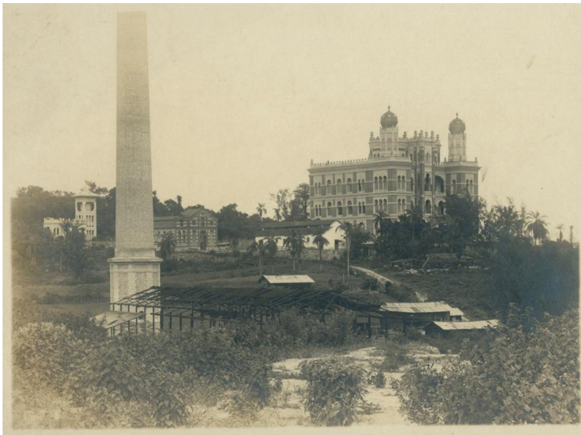
Figura 15: Chaminé com o Castelo de Manguinhos ao Fundo. Fonte: Base Arch Instituto Oswaldo Cruz. Código de referência: BR RJCOC 02-10-20-05-003-0
