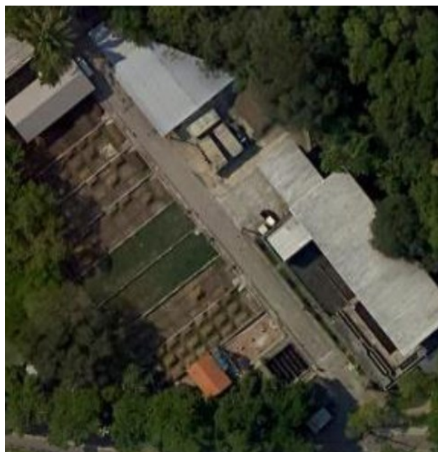
Figura 10. Vista aérea da ETE Fiocruz, campus Manguinhos
