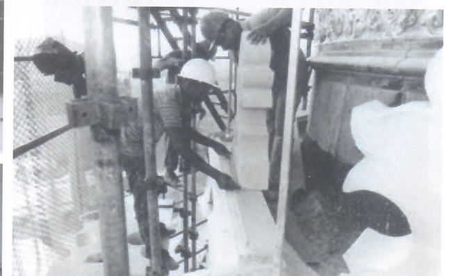
4-5. O estado avançado de degradação do revestimento original comprometia a integridade da torre, obrigando sua substituição por réplicas fabricadas em canteiro (fonte: Acervo DPH/COC/Fiocruz).
