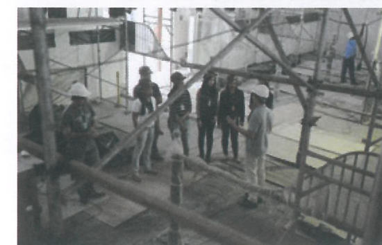
11-12. Obra de intervenção na Cavaleriça que contou com programa de educação patrimonial, que incluía ações desde a instalação de tapumes informativos, até visitas guiadas em forma de canteiro aberto (fonte: Acervo DPH/COC/Fiocruz).
