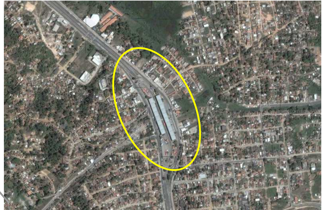
Terminal da PE-15
