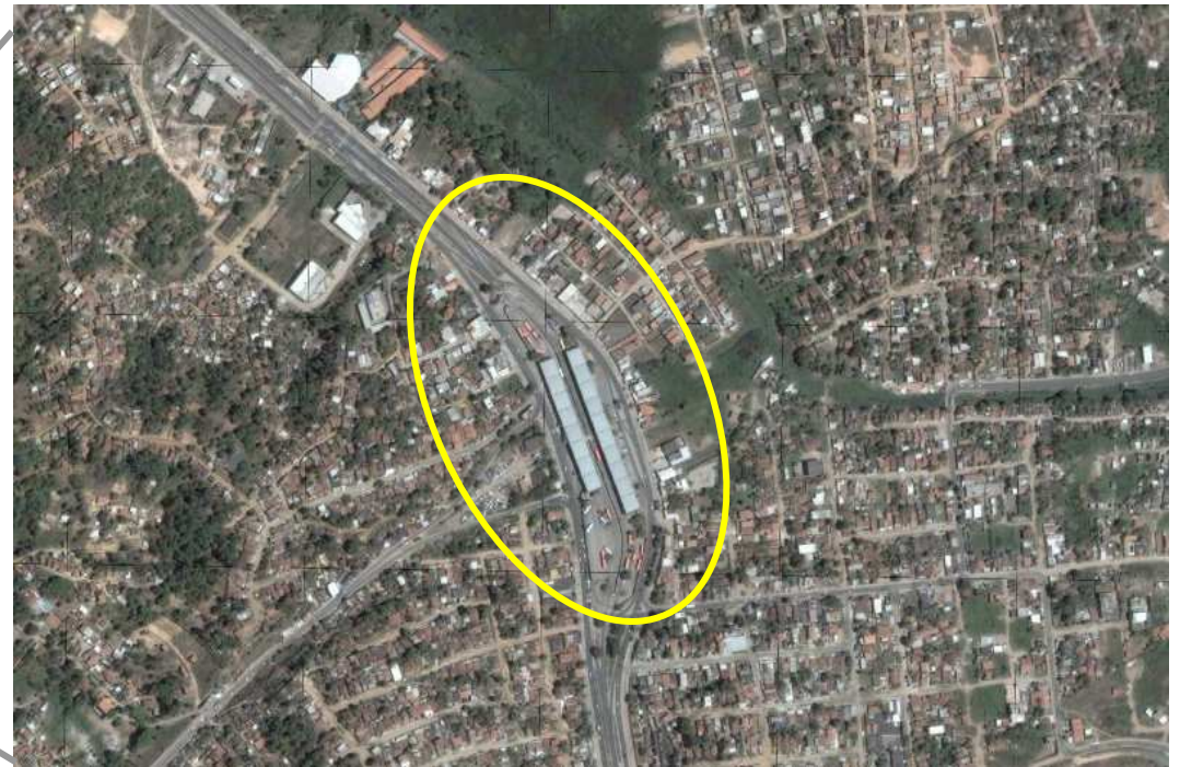
Terminal da PE-15
