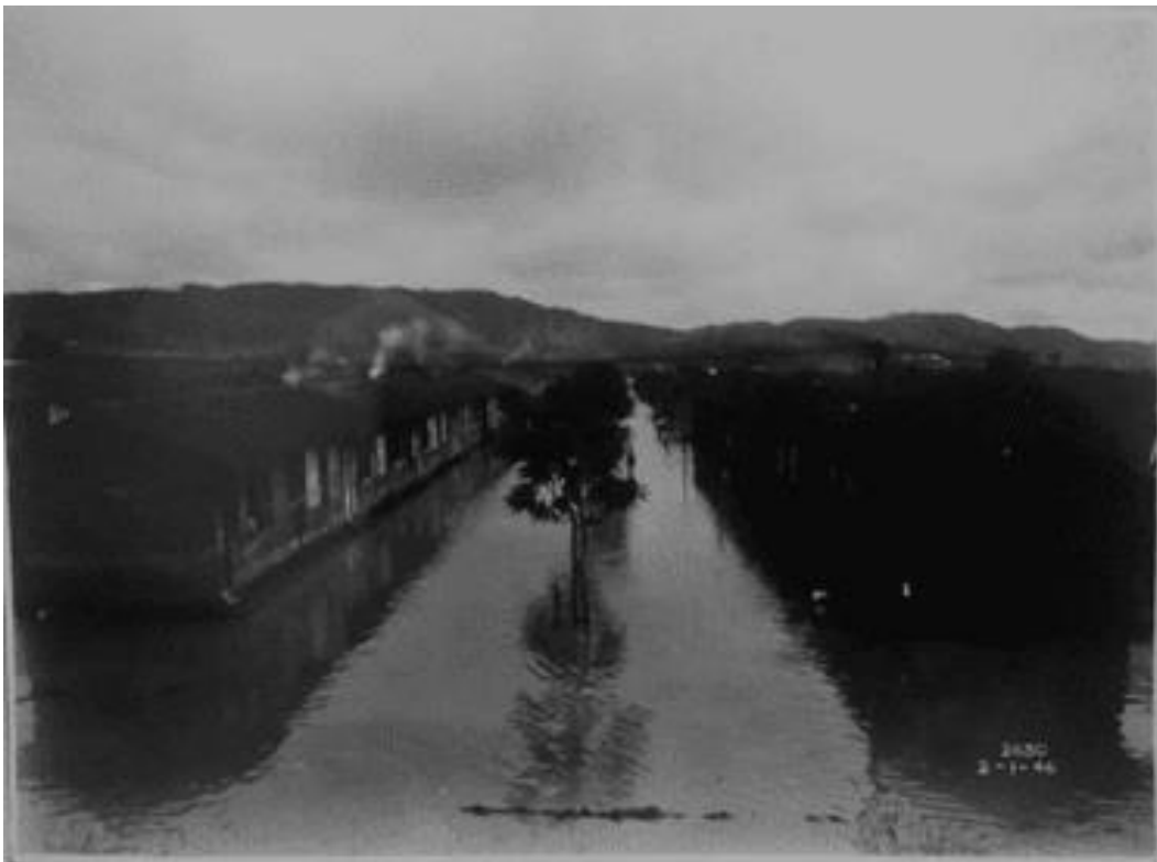
Figura 22 – Acampamento central alagado II. Fonte: Acervo CSN.
