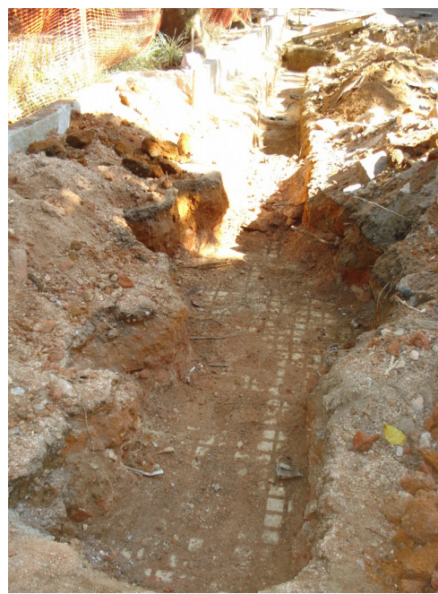
Figuras 17 e 18: A aparência da trincheira aberta pelos operários para a obra de modernização da rede de telefonia. A foto à esquerda mostra o trecho do piso da estrebaria que foi destruído e à direita o piso salvo. Fonte: DPH/COC/Fiocruz.
