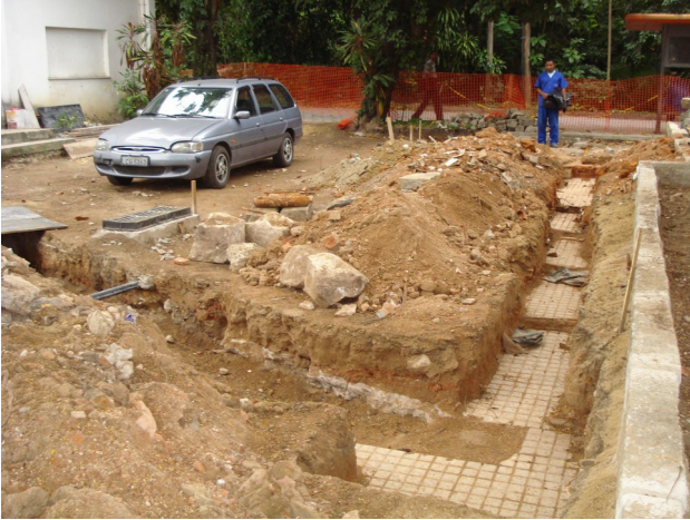
Figuras 40 e 41: Vestígios do piso e de uma coluna da Estrebaria construída na terceira década do século XX, localizado no estacionamento do Museu da Vida durante obras de movimentação de terra. O piso encontrado, que sobreviveu por quase setenta anos, foi parcialmente destruído antes da paralisação das obras. Fonte: Acervo DPH/ COC/Fiocruz.
