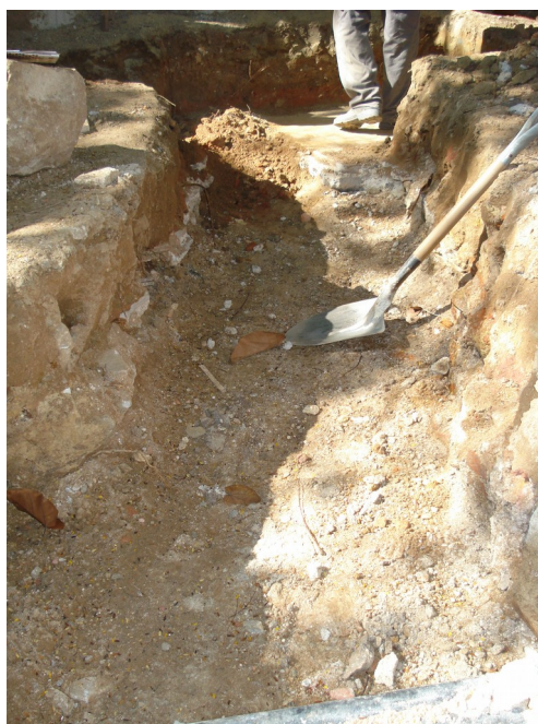
Figuras 17 e 18: A aparência da trincheira aberta pelos operários para a obra de modernização da rede de telefonia. A foto à esquerda mostra o trecho do piso da estrebaria que foi destruído e à direita o piso salvo. Fonte: DPH/COC/Fiocruz.
