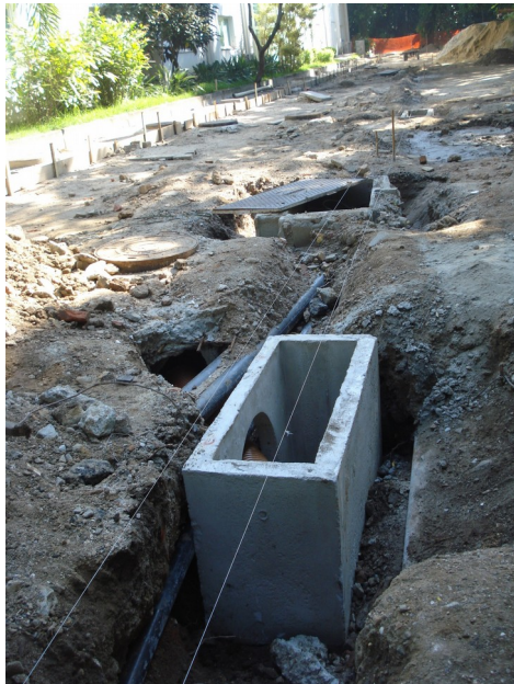
Trabalho de abertura de valas e buracos para a obra de drenagem do estacionamento do MV. Fonte: DPH/COC/FIOCRUZ
