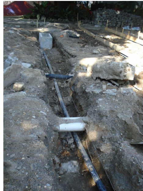
Trabalho de abertura de valas e buracos para a obra de drenagem do estacionamento do MV. Fonte: DPH/COC/FIOCRUZ
