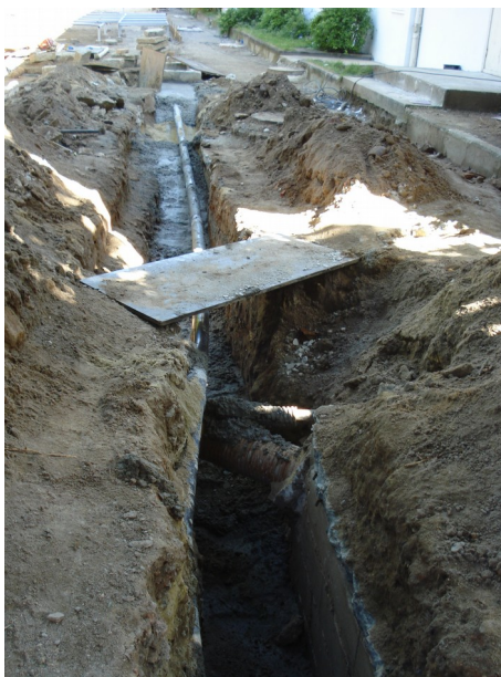
Passagem alternativa através da galeria já existente. Fonte: DPH/COC/FIOCRUZ
