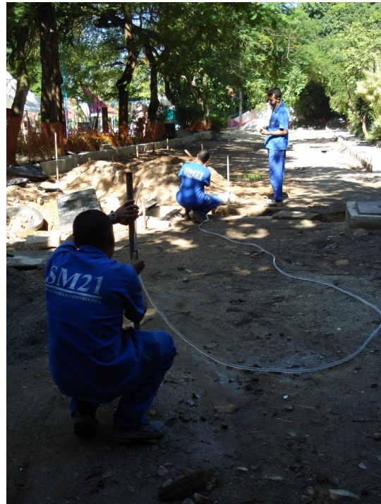
Execução de serviço de levantamento para determinar os níveis do piso da estrebaria em relação à rua. Fonte: DPH/COC/FIOCRUZ.
