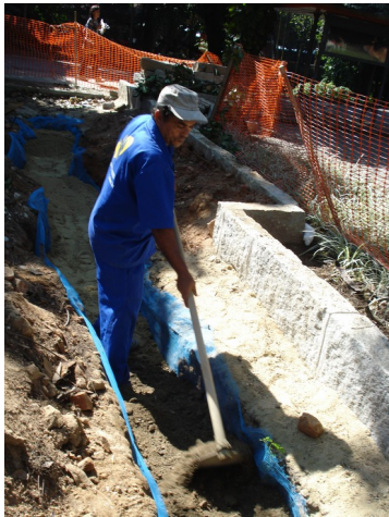
Preenchimento com terra e fechamento da trincheira. Fonte: DPH/COC/FIOCRUZ.
