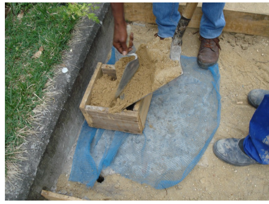
Procedimento adotado em todos os três vestígios de coluna. Colocação da tela fachadeira e preenchimento com areia. Fonte: DPH/COC/FIOCRUZ.
