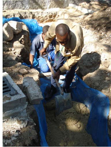
Etapas do fechamento da trincheira. Colocação da tela fachadeira e preenchimento com camada de areia. Fonte: DPH/COC/FIOCRUZ.
