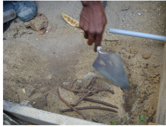
Detalhe da preparação da segunda e terceira coluna. Superfície limpa antes da colocação da tela fachadeira. Fonte: DPH/COC/FIOCRUZ.
