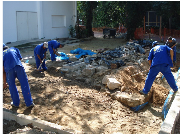
Preenchimento com terra e fechamento da trincheira. Fonte: DPH/COC/FIOCRUZ.
