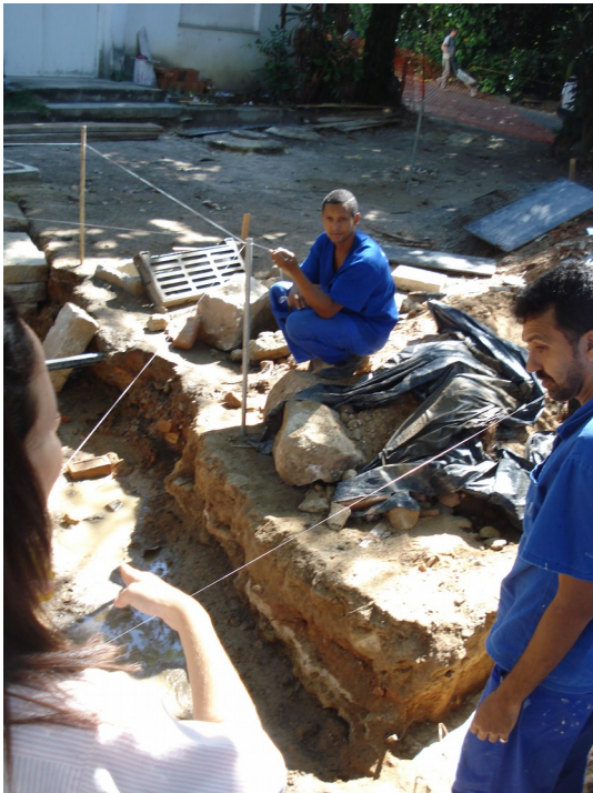
Execução de serviço de levantamento para determinar os níveis do piso da estrebaria em relação à rua. Fonte: DPH/COC/FIOCRUZ.
