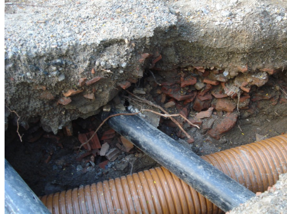
Camada de 8cm de material de entulho a 40 cm do solo (profundidade do buraco de 68cm). Fonte: DPH/COC/FIOCRUZ
