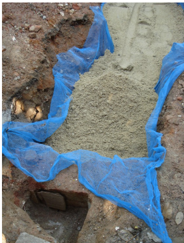
Preenchimento com terra e fechamento da trincheira. Fonte: DPH/COC/FIOCRUZ.
