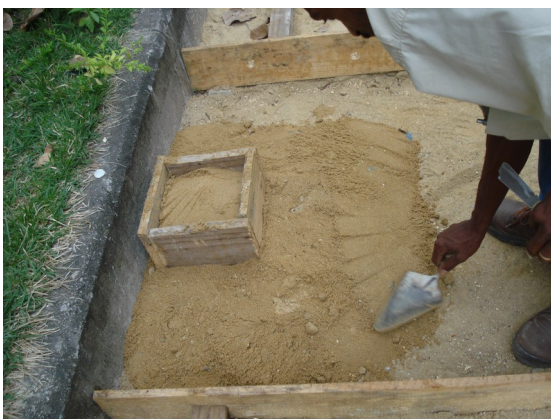
Após assentada a camada de areia, é colocada a camada de cimento. Fonte: DPH/COC/FIOCRUZ.
