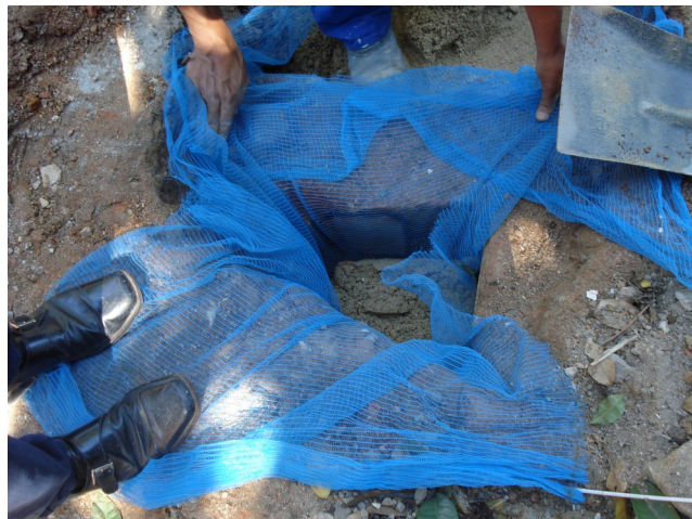
Preenchimento com terra e fechamento da trincheira. Fonte: DPH/COC/FIOCRUZ.
