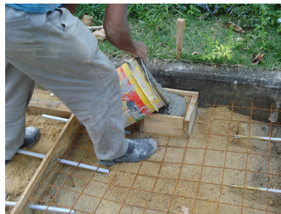
Após assentada a camada de areia, é colocada a camada de cimento. Fonte: DPH/COC/FIOCRUZ.
