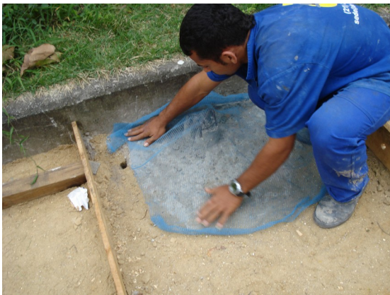
Procedimento adotado em todos os três vestígios de coluna. Colocação da tela fachadeira e preenchimento com areia. Fonte: DPH/COC/FIOCRUZ.
