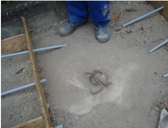
Detalhe da preparação da segunda e terceira coluna. Superfície limpa antes da colocação da tela fachadeira. Fonte: DPH/COC/FIOCRUZ.
