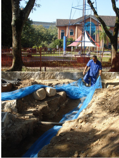
Etapas do fechamento da trincheira. Colocação da tela fachadeira e preenchimento com camada de areia. Fonte: DPH/COC/FIOCRUZ.
