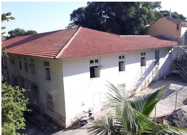
Figura 94 - Telhado reformado, em 2022.
