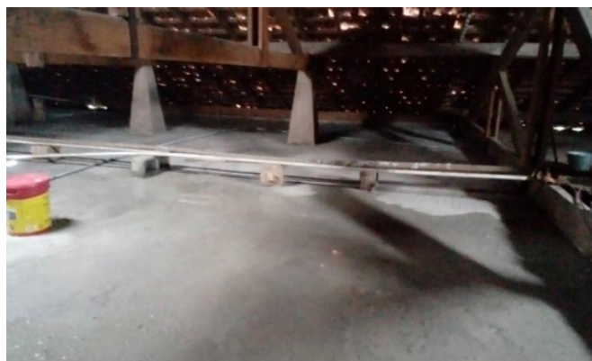
Figura 95 - Laje do edifício da Coordenação de Arquivos com impermeabilizante, em 2022.
