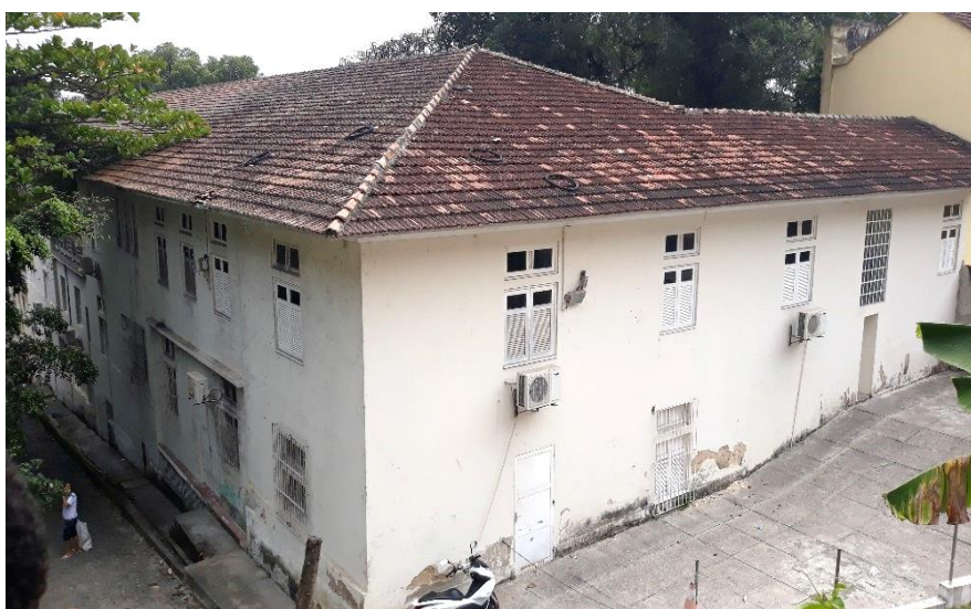
Figura 93 - Telhado antes da reforma, em 2020.
