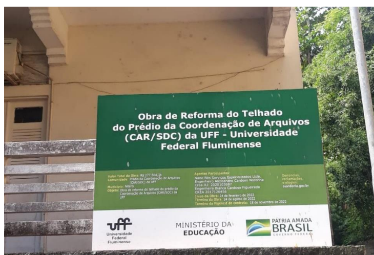
Figura 92 - Placa indicando a reforma do telhado do edifício da Coordenação de Arquivos da UFF, em 2022.
