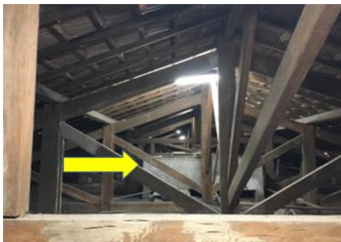
Figura 96 - Caixa d'água na laje do edifício da Coordenação de Arquivos, em 2021.
