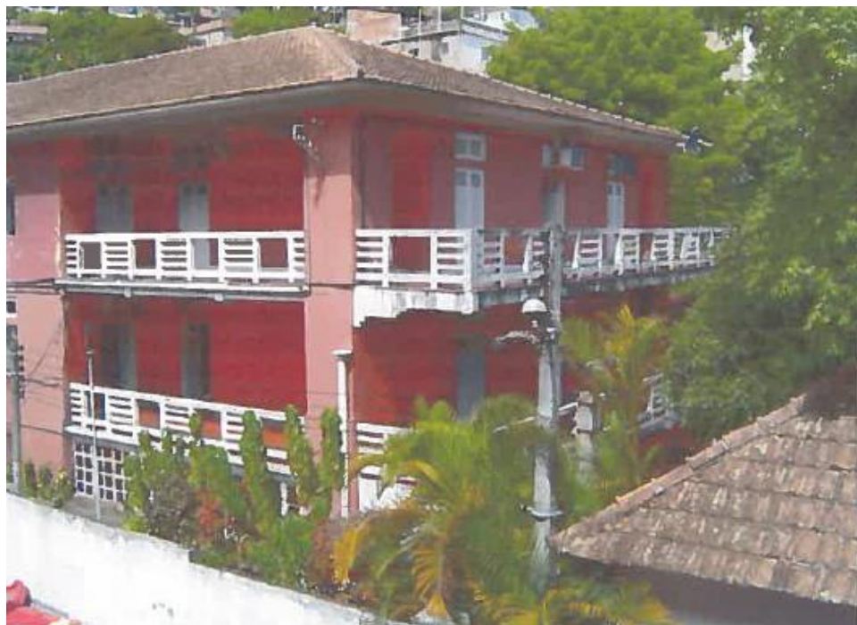
Figura 22 - Sede da Gerência de Arquivos/NDC, 1998, vista do edifício vizinho ao Pavilhão Central.
