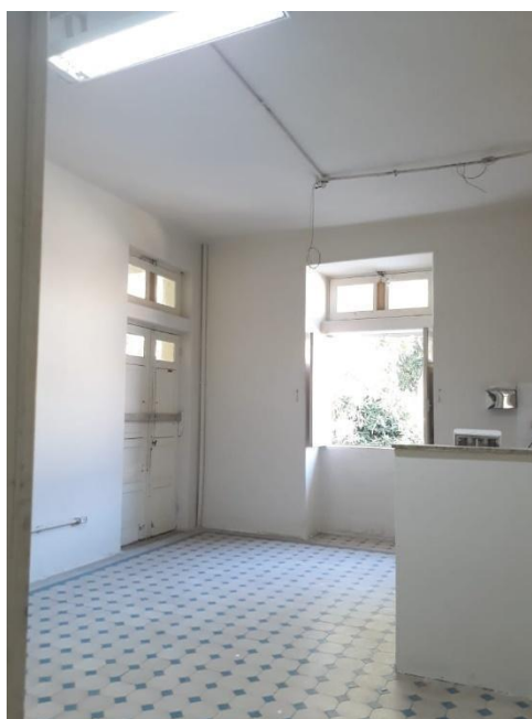
Figura 105 - Finalização do reparo no teto da copa do 2º pavimento, em 2022.
