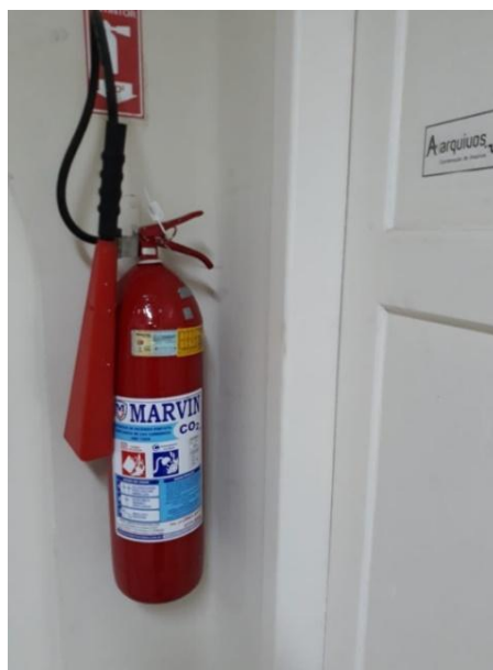
Figura 76 - Extintor CO 2 - para combate ao incêndio em produtos químicos inflamáveis e eletricidade.
