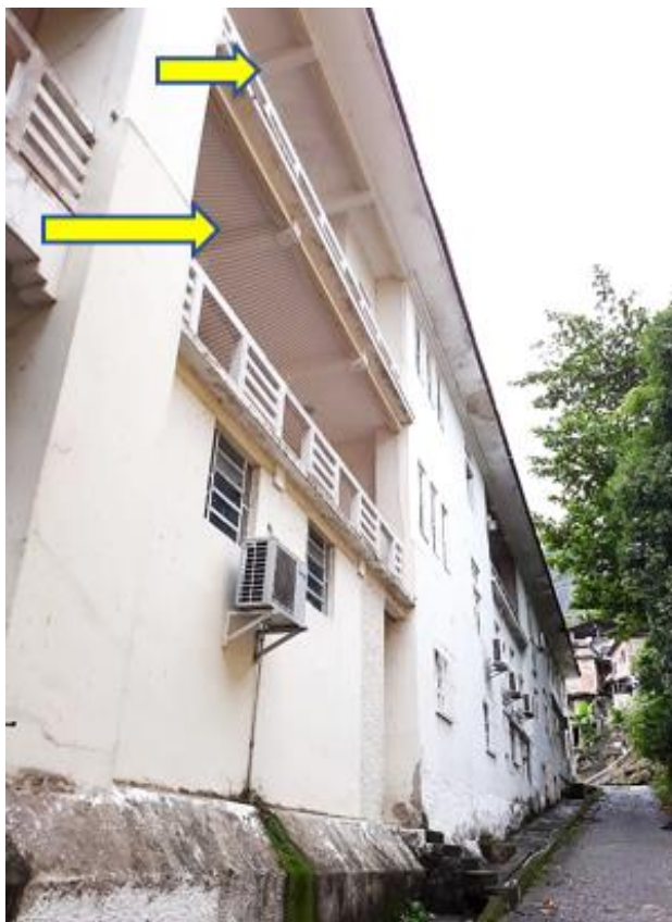
Figura 68 - Telas de proteção nas varandas do edifício para barrar a entrada de pombos, em outubro de 2021.
