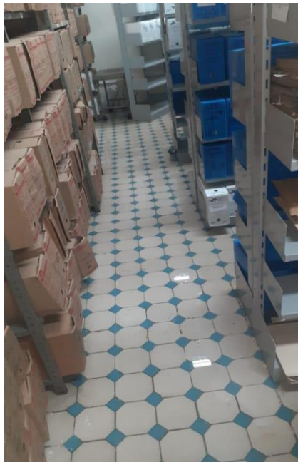
Figura 45 - Depósito de arquivo permanente com o chão alagado, em dezembro de 2021.
