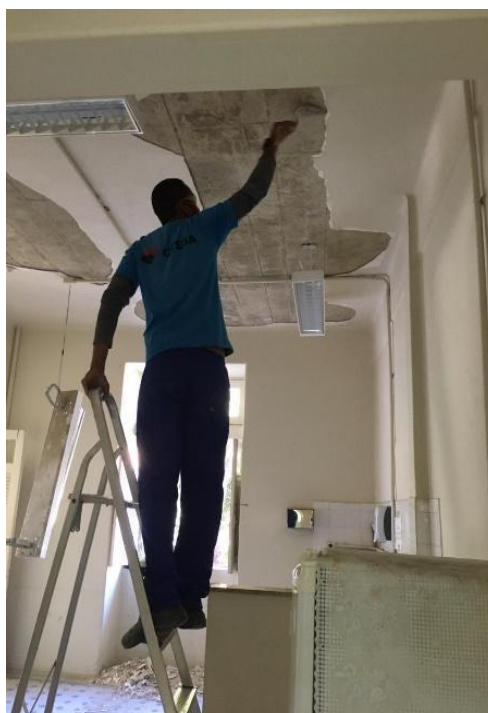
Figura 104 - Início do reparo emergencial do teto da copa do 2º pavimento, em 2021.
