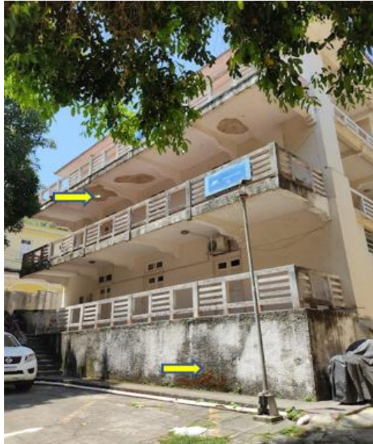
Figura 32 - Fachada do prédio da Coordenação de Arquivos, em 2021.
