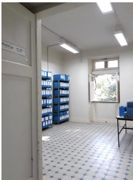
Figura 103 - Teto da sala de arquivo especial reformado em 2022.
