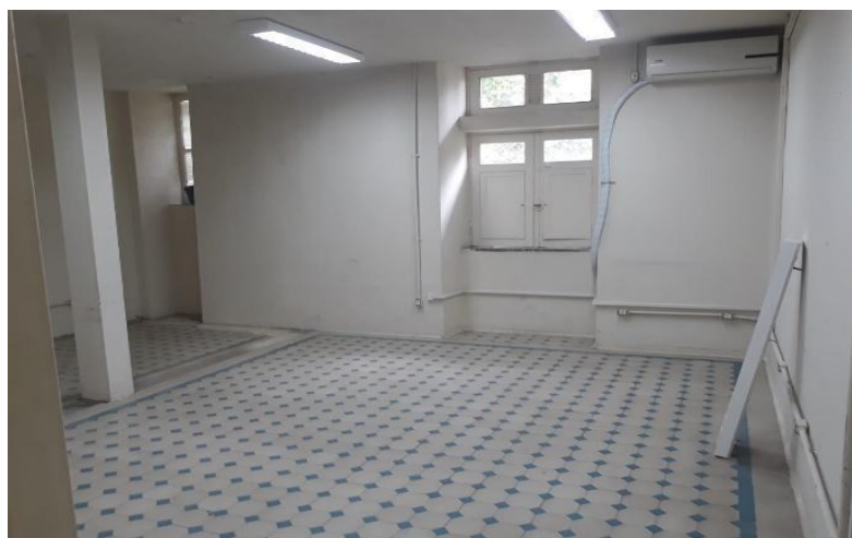
Figura 43 - Depósito arquivo intermediário vazio aguardando a reforma, dezembro de 2021.
