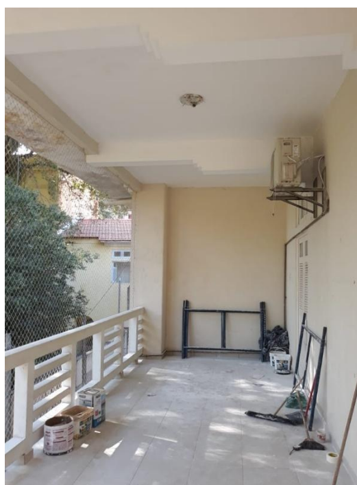
Figura 107 - Varanda do 2º pavimento reformada, em 2022.
