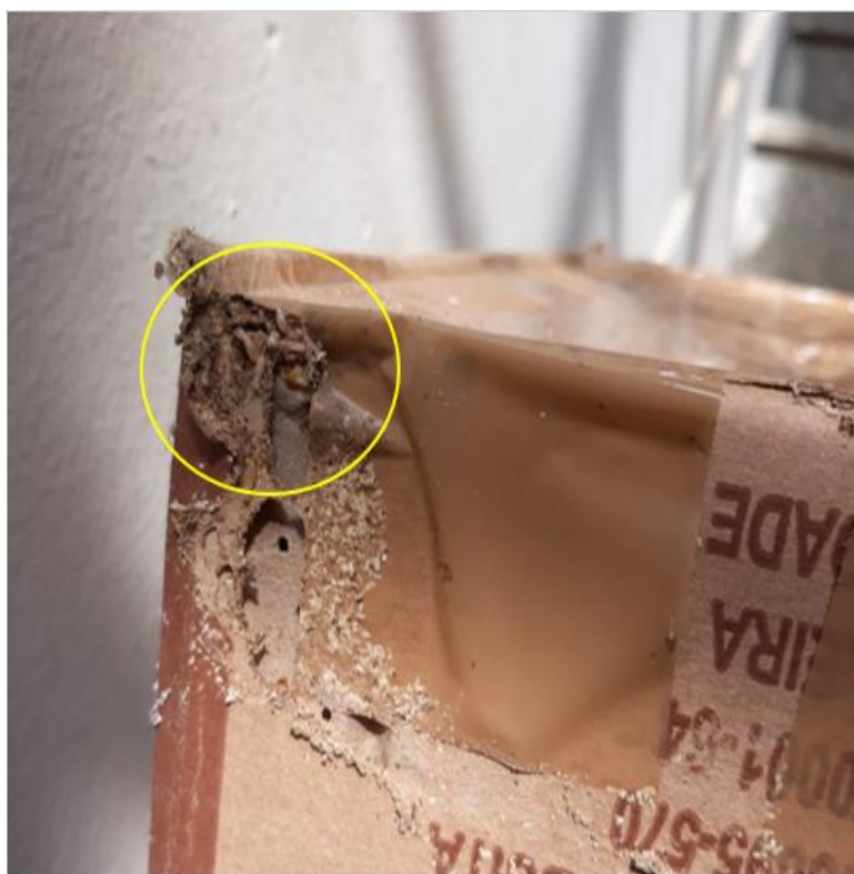
Figura 64 - Presença de infestação de cupim em caixas de documentos com destinação de eliminação, em 2021.
