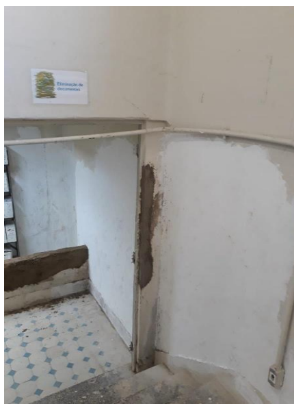
Figura 101 - Sala de eliminação de documentos em reforma, 2022.
