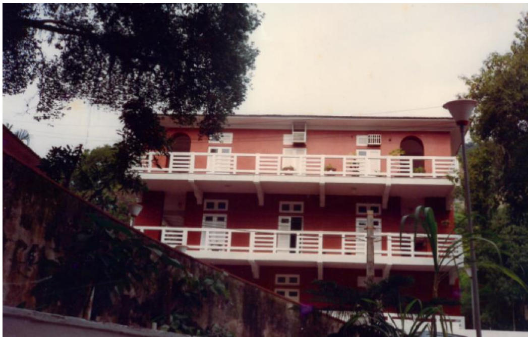
Figura 19 - Sede da Gerência de Arquivos/NDC após reforma de 1998.
