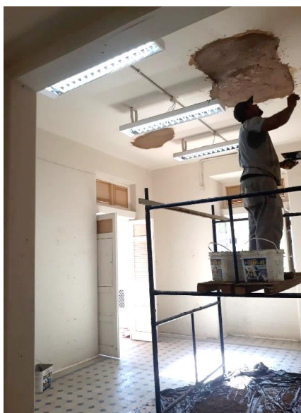
Figura 99 - Reforma da sala de depósito de Arquivo Permanente, 2022.
