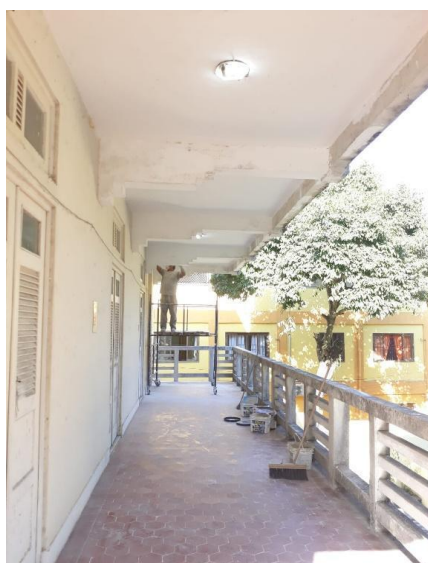
Figura 109 - Teto da varanda do 1º pavimento sendo reformado, em 2022.
