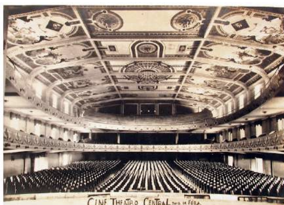
Figura 32 - Interior do prédio em 1940.
