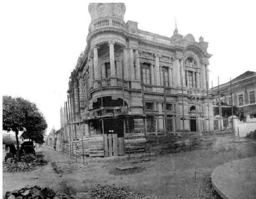
Figura 28 - Construção do prédio das Repartições Municipais, 1918.
