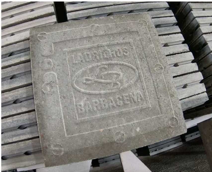
Figura 69 - Costas do ladrilho hidráulico produzido pela fábrica Ladrilhos Barbacena.
