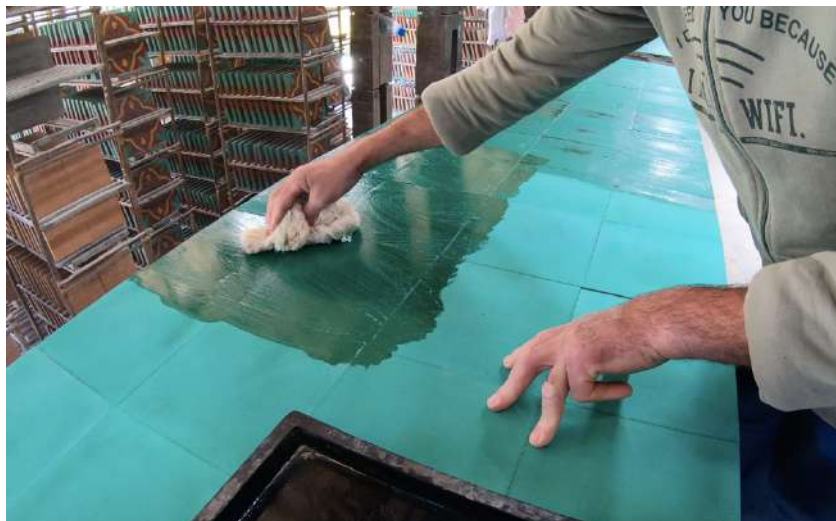
Figura 85 - Aplicação do óleo hidrofugante.
