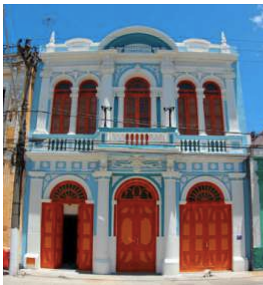
Figura 26 - Fachada da Associação Comercial de Juiz de Fora.
