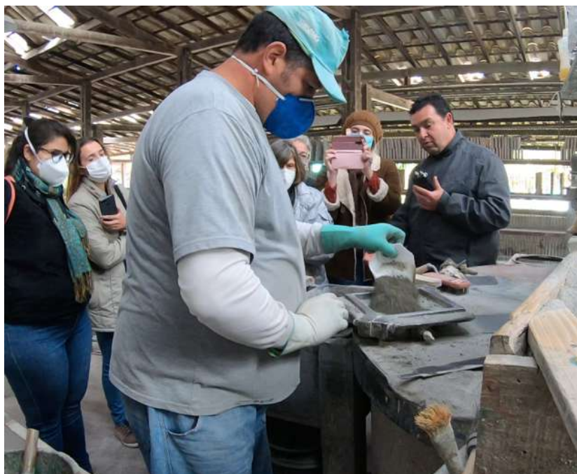
Figura 77 - Aplicação da terceira camada.
