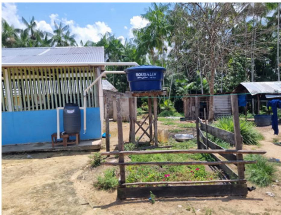
**Foto 14.** Protótipo de aproveitamento de água de chuva instalado em frente da cozinha da Escola Municipal Indígena Omawe.
