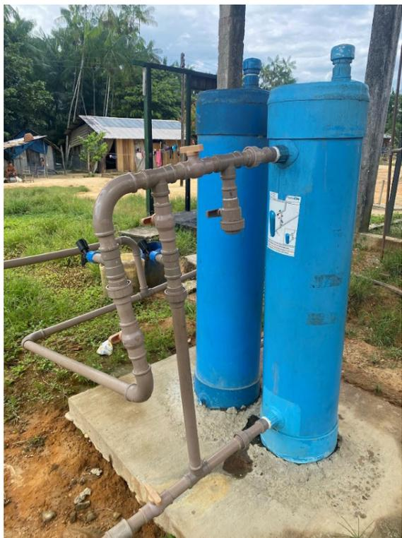
AS1 – Detalhe da filtração do Salta-Z em Ariabú
