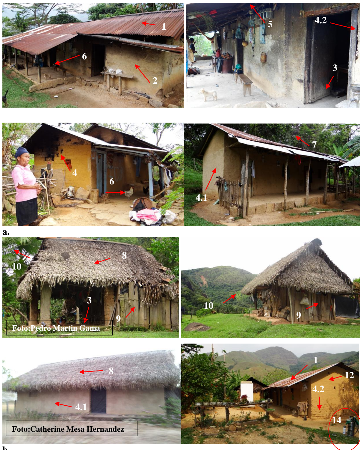
b. Figura 5.4. Modelos de domicílios da área rural de Támara, estado de Casanare, evidenciando os componentes predominantes em sua estrutura física, 2011: a. teto de zinco (1), parede de adobe (2), chão de terra batida (3), parede parcialmente rebocada (4), completamente rebocada (4.1), não rebocada (4.2) com frestas entre o teto e a parede (5) presença de animais domésticos (6) e vegetação no peridomicílio (7); b. Teto de palha (8), parede de madeira (9), chão de terra batida (3), presença de palmeiras (10), parede de pau-a-pique (12), máquina X-pert para aplicação de piretroide (14)
