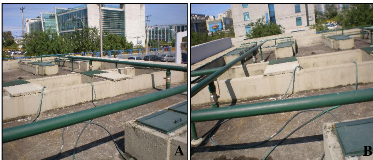
Figura 4 (A e B). Vista panorâmica da estação de tratamento de esgoto estudada
