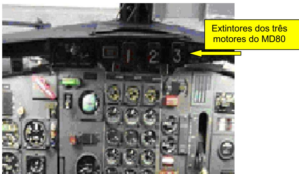
Figura 159- Extintores de fogo do MD80 Fonte: acervo do autor(2004)
