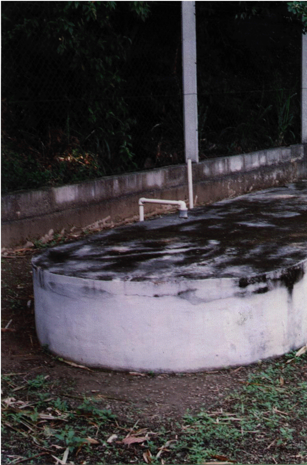
Foto V.2 – Canto em curva da Unidade Anaeróbia
