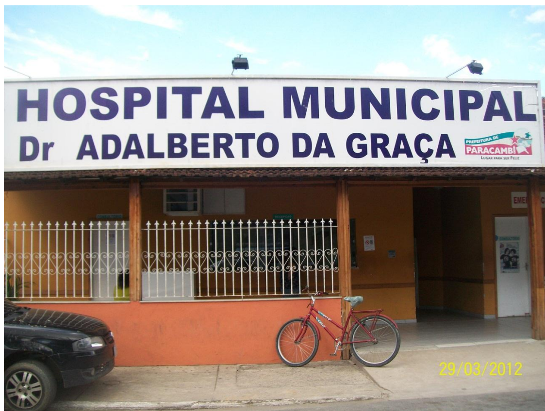
Figura 14: Fachada do Hospital Geral Municipal. Fonte: Arquivo pessoal da autora
