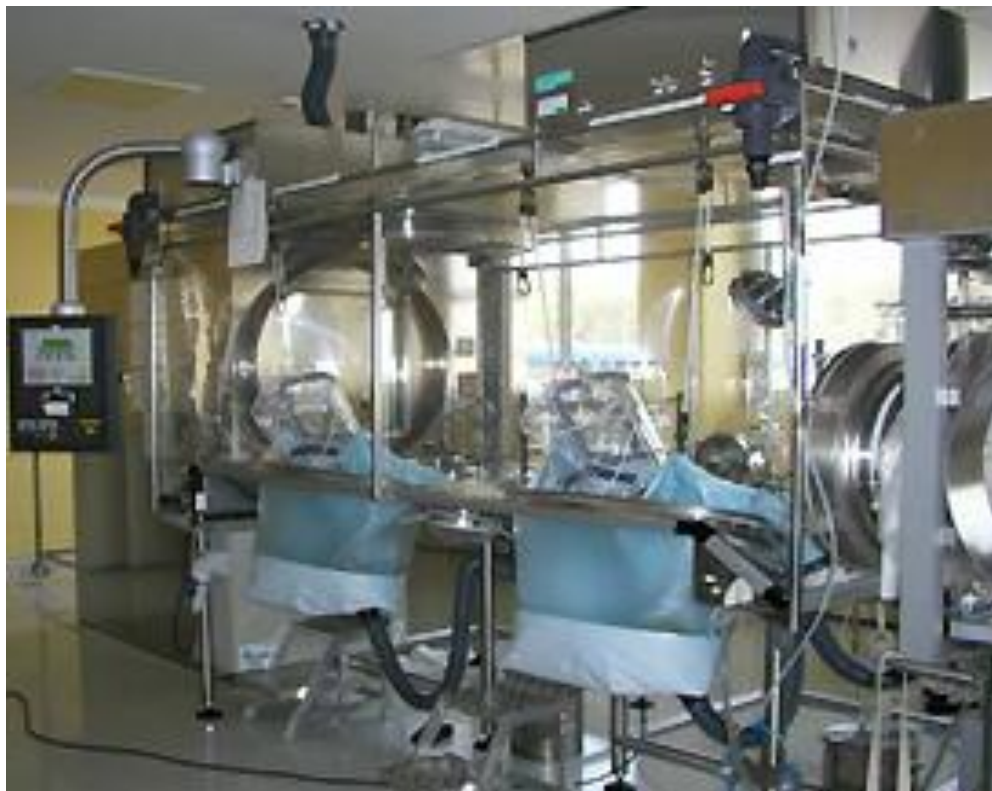
Figura 7: Sala do isolador em ambiente classe D
