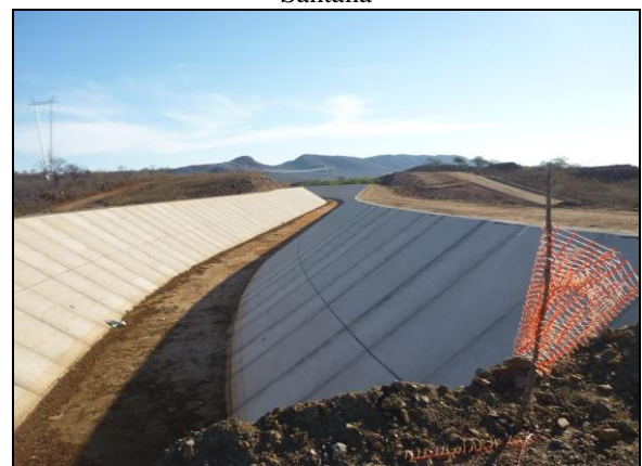
Figura 5 - Obras do canal - Território do Quilombo de Santana
