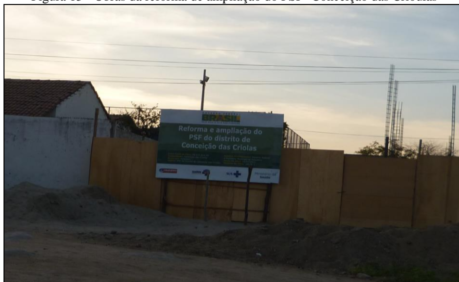
Figura 13 - Obras da reforma de ampliação do PSF- Conceição das Crioulas
