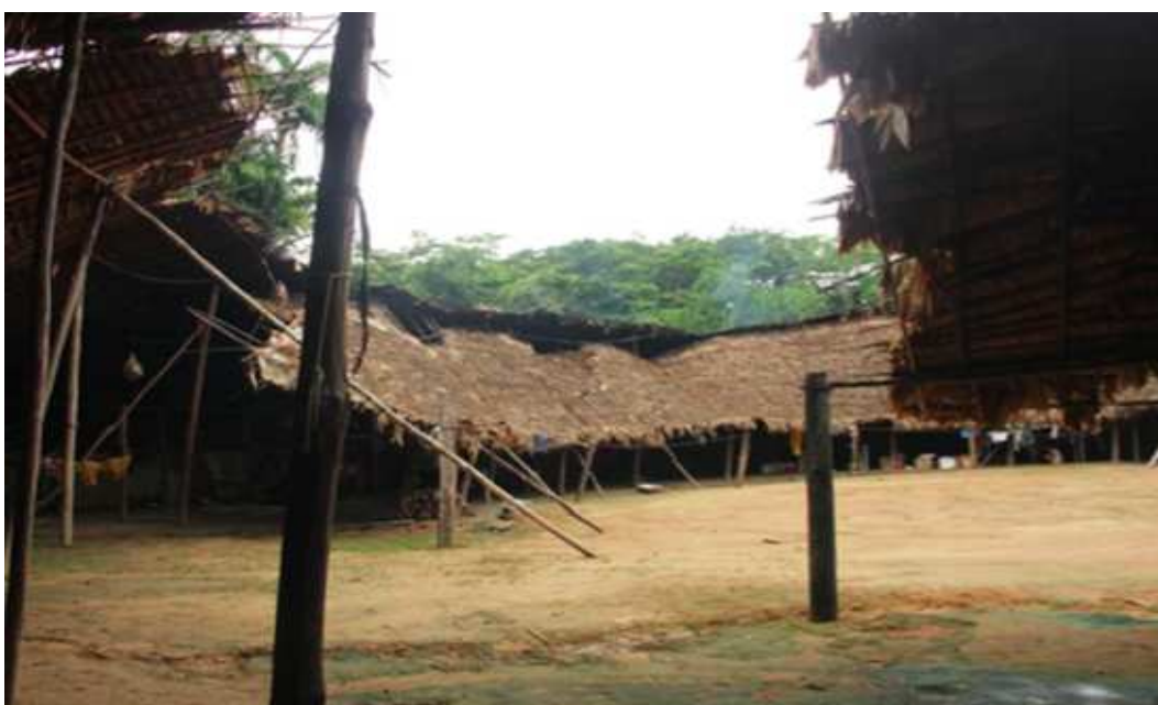
Figura 3. Visão interna do shabono da comunidade de Taibrapa, onde pode-se observar as estruturas em palha e madeira, assim como a ausência de repartições internas. Fonte: Tese Doutorado Jordi Ribas, 2015.
