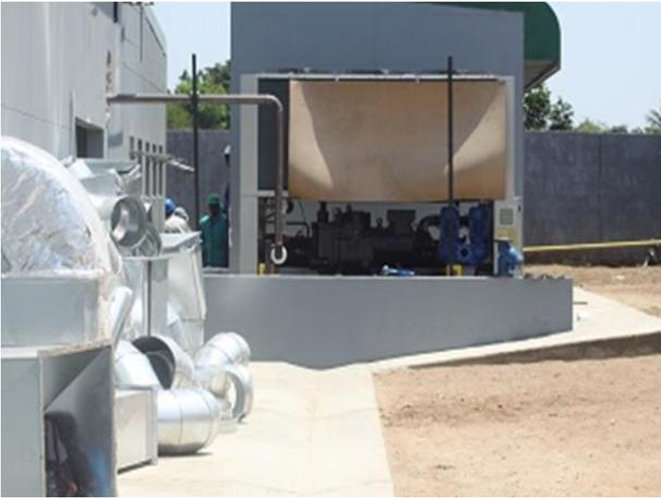
Foto 07 – Chiller instalado na SMM (Fev. 2012)
