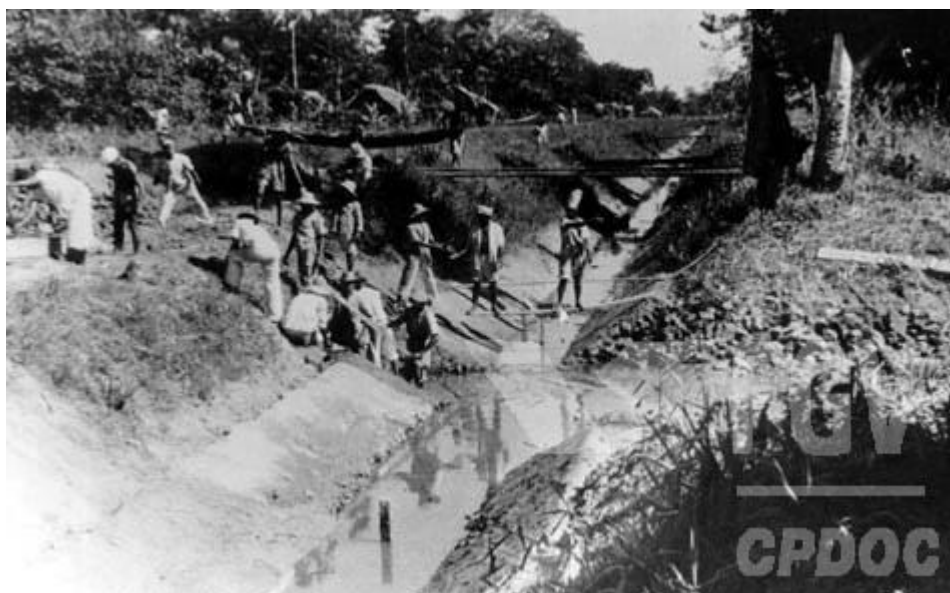
Construção do Dique de Belém (entre 1934-45). Belém (CPDOC/AGC/ Foto 823)
