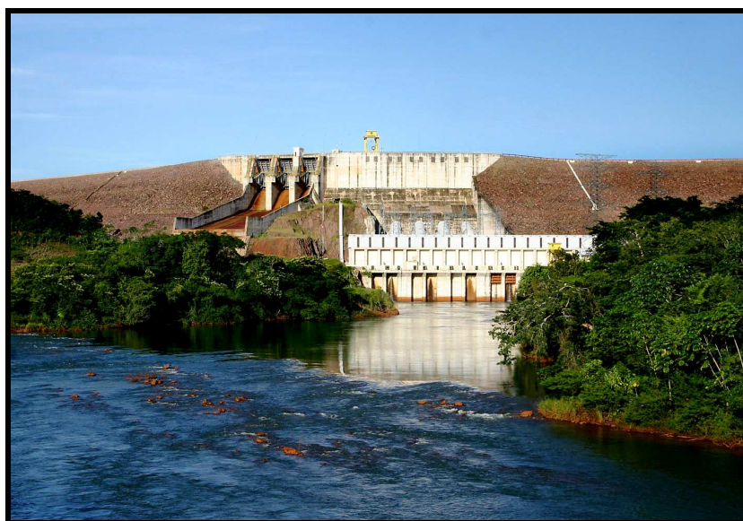
Figura 7 – Vista frontal das turbinas do Aproveitamento Múltiplo de Manso
