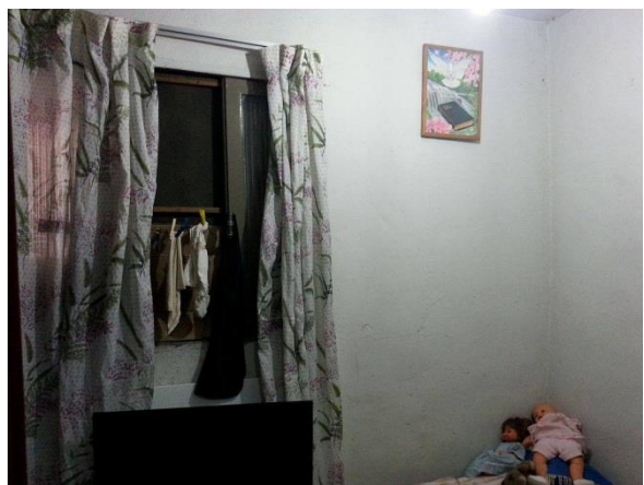
Figura 4.4 A janela (parcialmente obstruída pela casa vizinha) do domicílio. Fonte: Própria.
