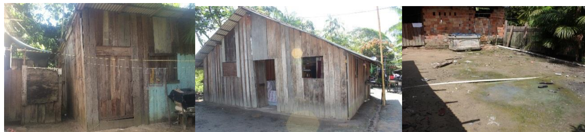
Figura 11 – Características habitacionais do distrito do Murinin, Benevides, Pará Fonte: Do autor.
