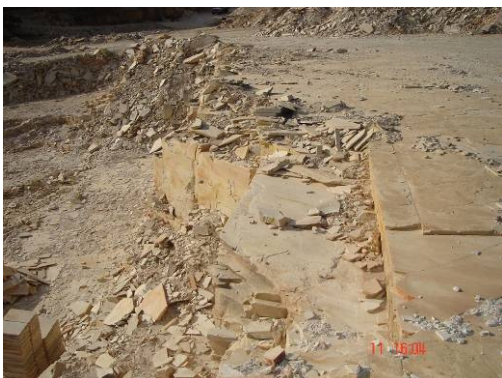
Figura 04: Área da pedreira após explosão
