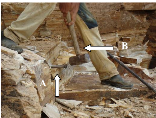
Figura 05: A) Posicionamento da cunha no veio da pedra e B) utilização da marreta para encaixar a cunha.
