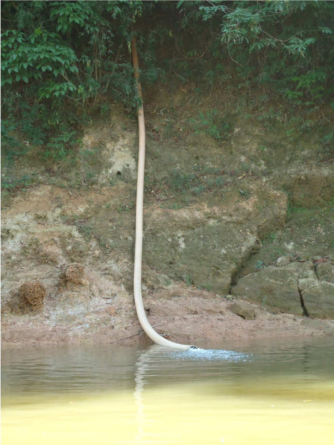
Figura 14: Mangueira de despejo do efluente do Curtime A
