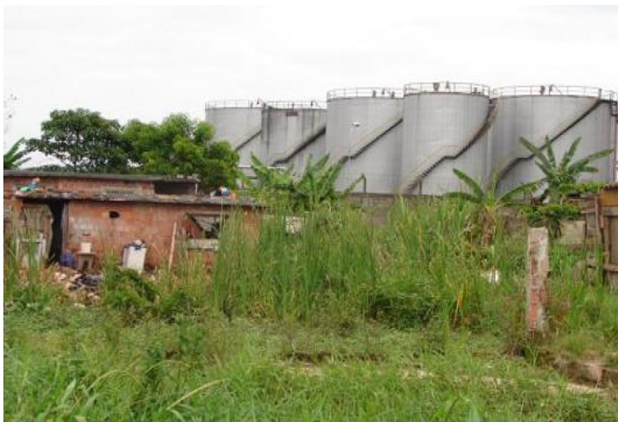
FIGURA 5. Situação comum em Campos Elíseos, onde moradias são afixadas próximas aos tanques de distribuidoras de combustíveis do Pólo Petroquímico. Fonte: Raulino, S.F. (2009) citado em VAZ, 2013.
