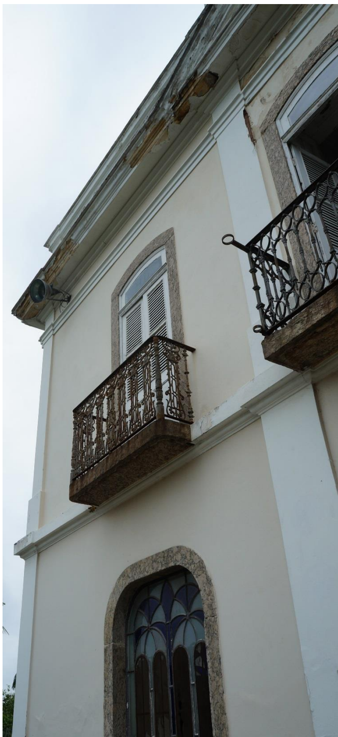
Figura 32 – Ausência de ornamentos na fachada e oxidação dos gradeamentos
