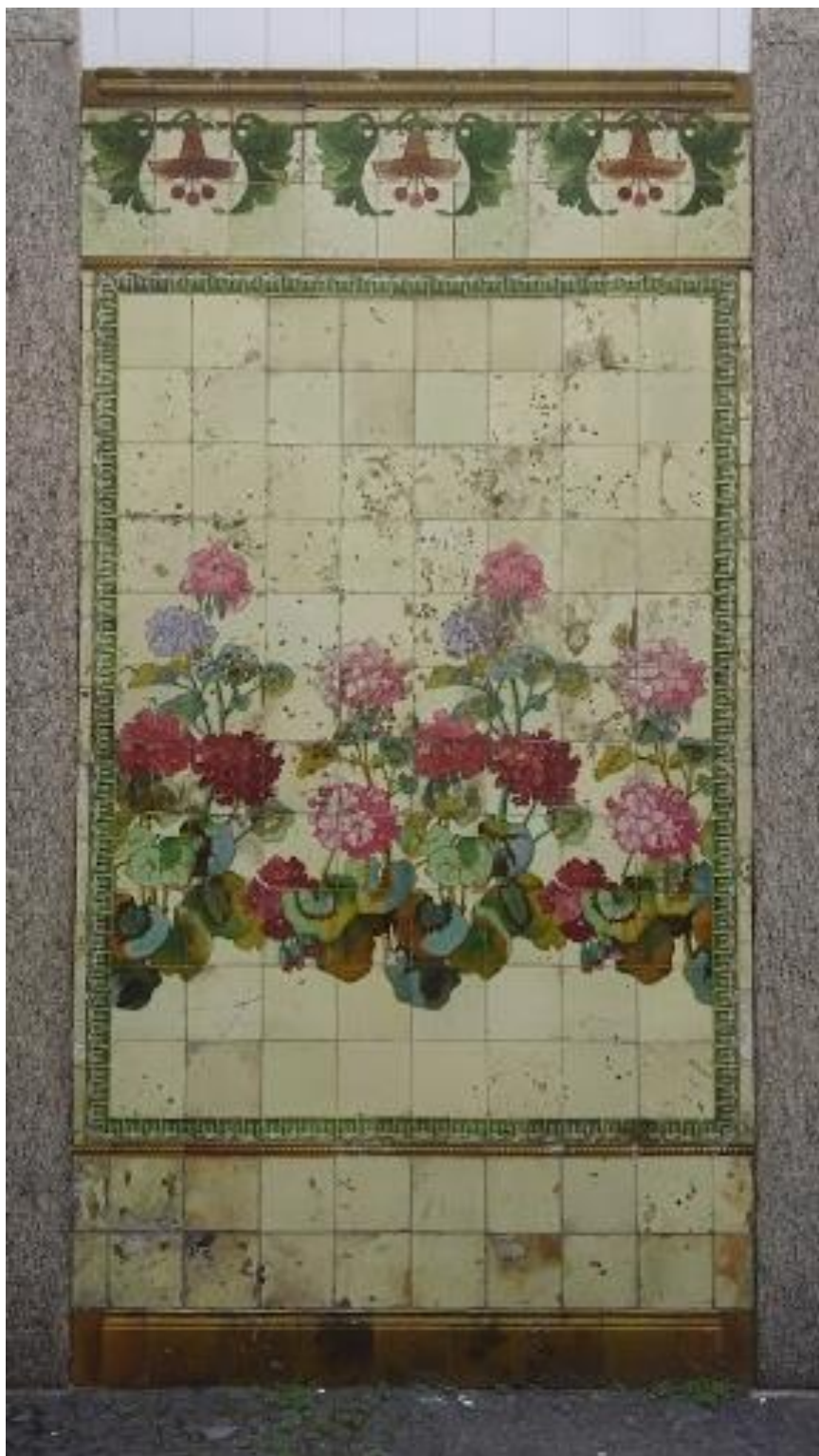
Figura 35 – Sujidades, infiltrações e perda da camada pictórica no painel azulejar
