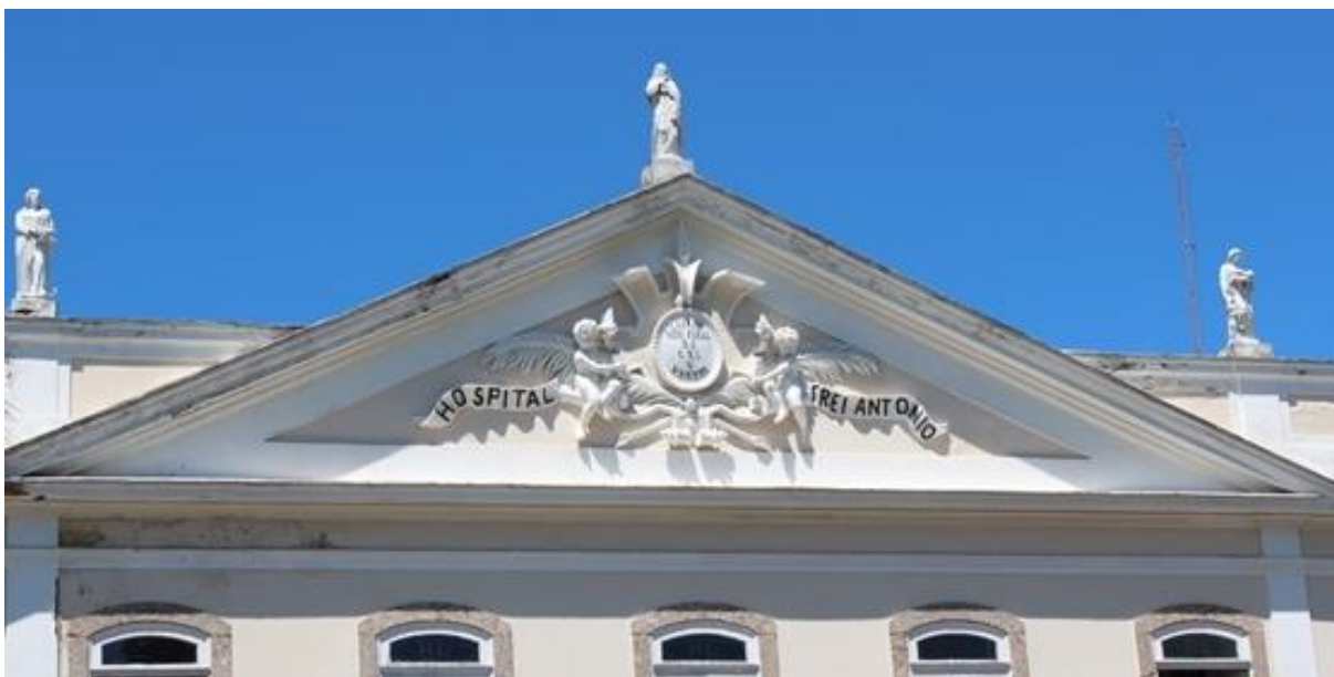
Figura 33 – Perda de reboco, crostas negras e infiltrações na fachada posterior do HFA
