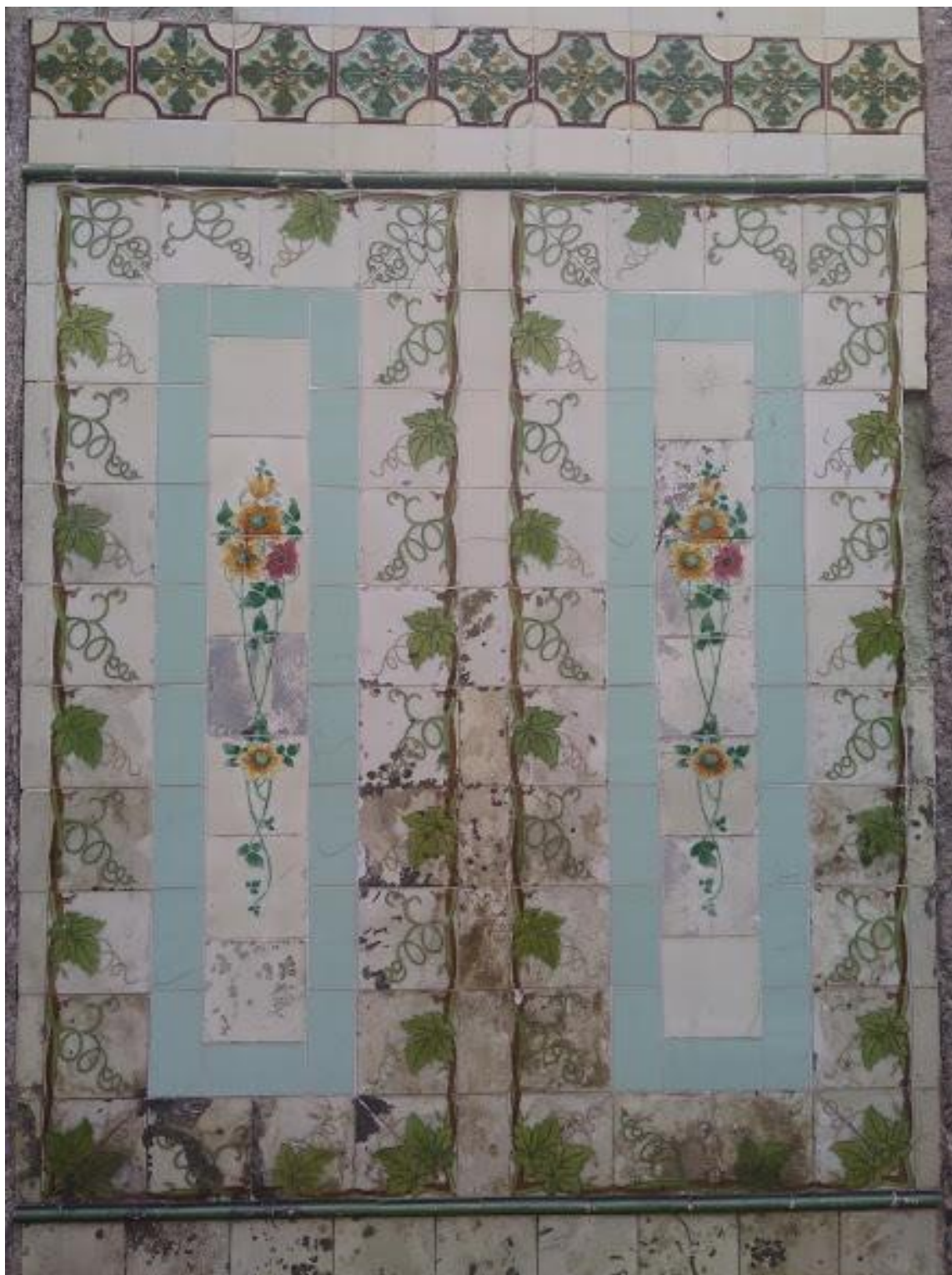
Figura 36 – Comprometimento da camada pictórica e ausência de revestimentos azulejares
