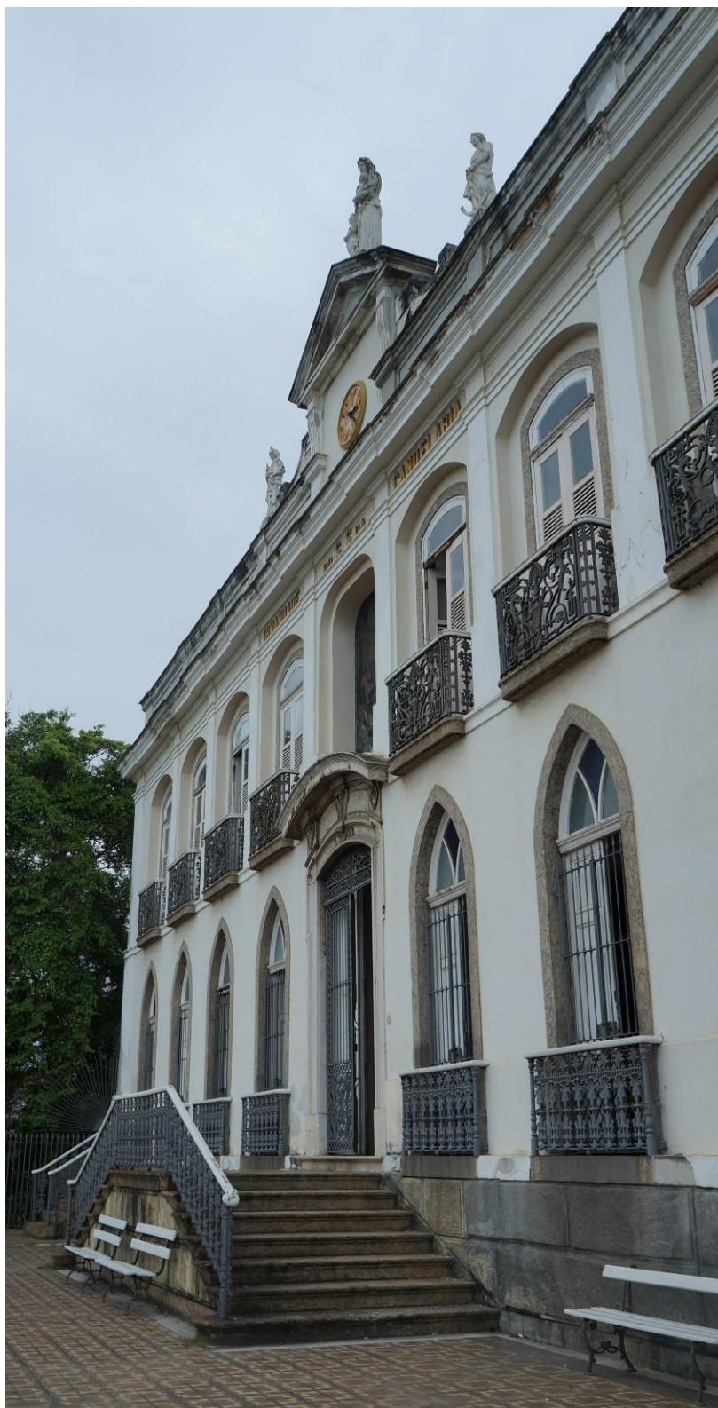
Figura 31 – Crostas negras, infiltrações e sujidades na fachada principal do HFA
