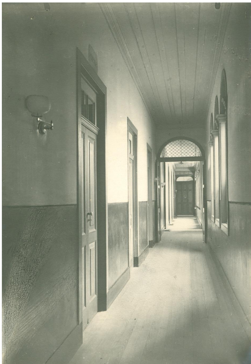
Figura 14 – Corredor do 2º pavimento
