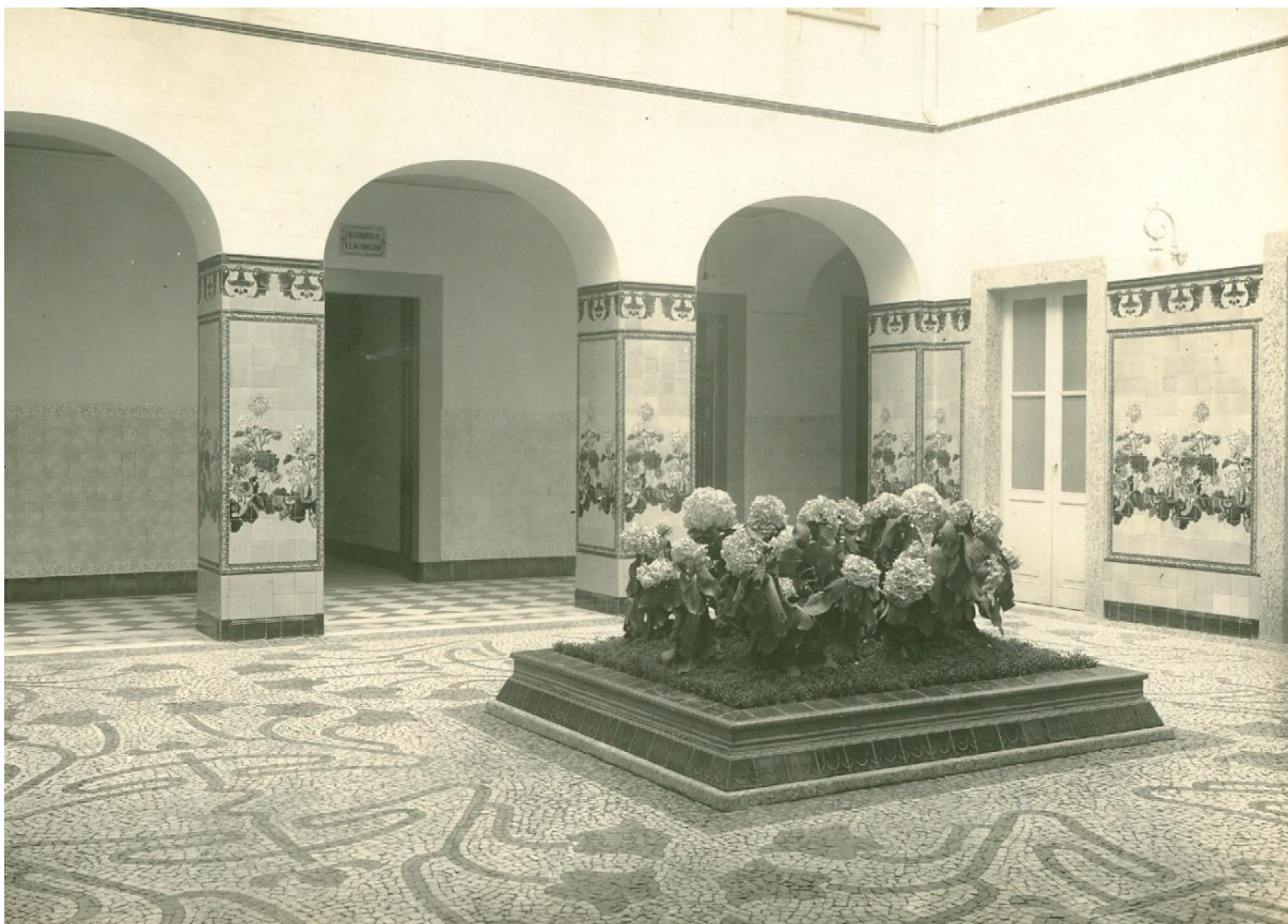
Figura 15 – Pátio interno com gerânios ao centro
