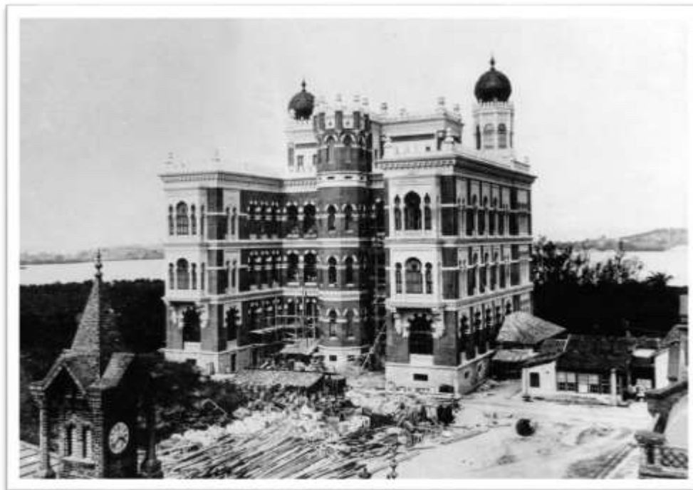
Figura 1 - Pavilhão Mourisco em obras, Manguinhos, Rio de Janeiro, 1907
