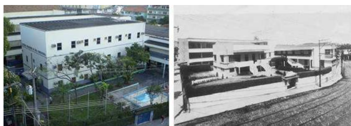
Figura 62 - Colégio Brasileiro de São Christovão, Rua Fonseca Teles nº 177, São Cristóvão, Rio de Janeiro, s/d.
