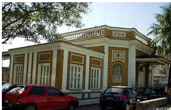
Figura 11 - Estação Ferroviária de São Cristóvão, Avenida Oswaldo Aranha n° 680, em São Cristóvão, Rio de Janeiro, s/d.
