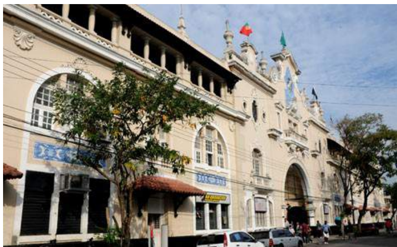
Figura 15 - Estádio São Januário, do Clube de Regatas Vasco da Gama, Rua General Almérico de Moura nº 131, Vasco da Gama, Rio de Janeiro, s/d.
