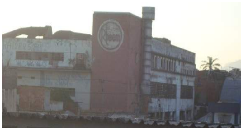
Figura 34 - Antiga fábrica da Rheem Química, Rua Prefeito Olympio de Melo nº 721, em Benfica, no Rio de Janeiro, 2011.
