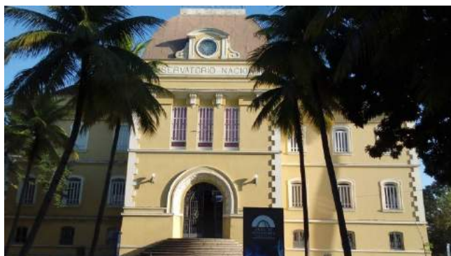
Figura 28 - Observatório Nacional, Rua General Bruce nº 586, em São Cristóvão, Rio de Janeiro, 2018.
