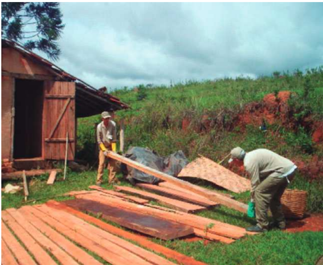
Figura 3 – Preparação de anexo para borrifação: disposição da madeira para recebimento da borrifação. Foto: Dr. Bernardino Vêz de Melo Azeredo.
