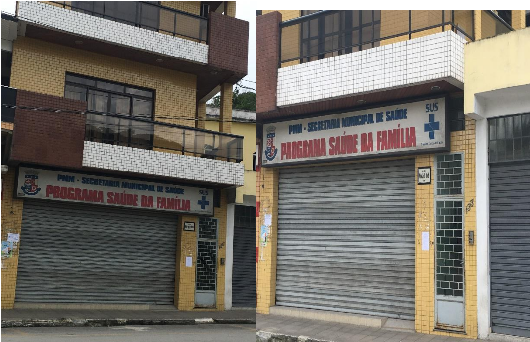
FOTO 1: SECRETARIA MUNICIPAL DE SAÚDE SEM RAMPA E ELEVADOR
