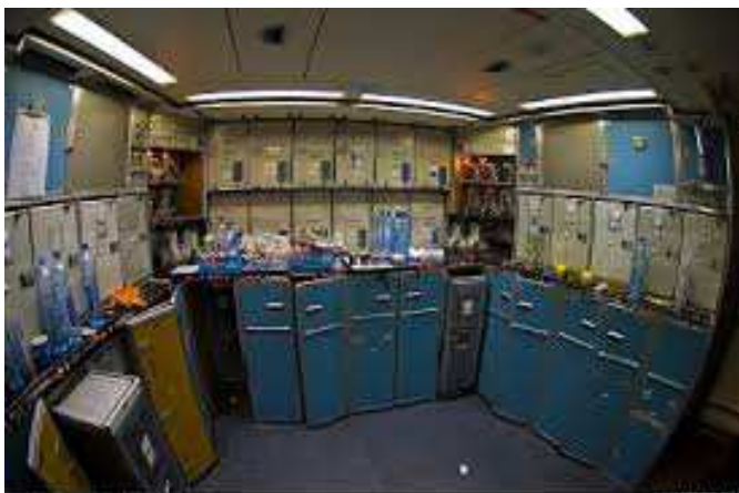
Figura 2 – Foto de Galley tirada durante a visita técnica
