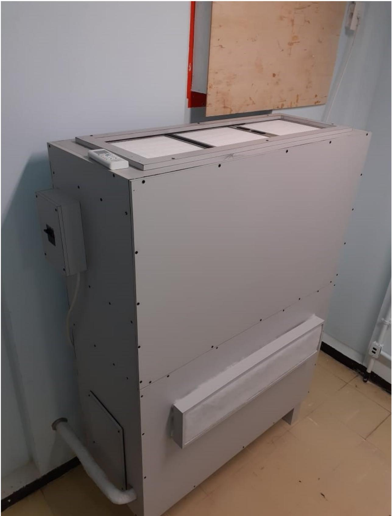
Em virtude da alta transmissibilidade do vírus em UTIs, é necessário que as unidades de isolamento sejam dotadas de um sistema de circulação que impeça que o ar contaminado seja disseminado em outros ambientes, como também no meio externo, demandando critérios específicos de filtragem para o devido tratamento. Os procedimentos que podem gerar aerossóis em pacientes com Covid-19 devem ser realizados preferencialmente em uma unidade com isolamento respiratório com pressão
