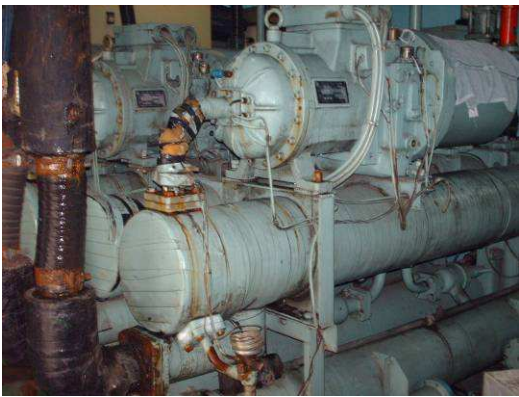
Figura 44: Compressores
