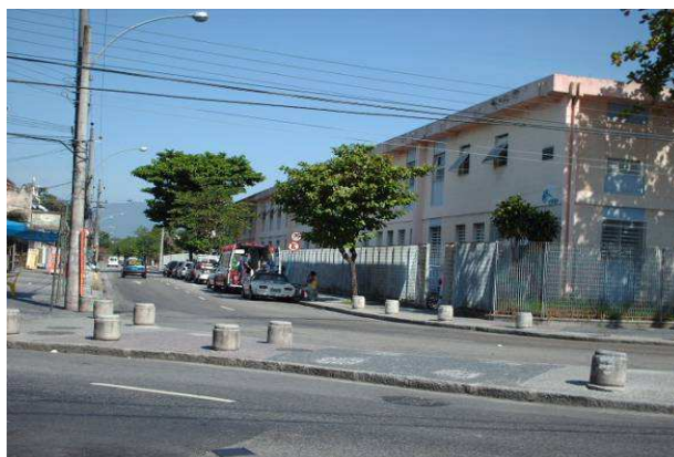
Figura 01: Fachada lateral esquerda do HECC
