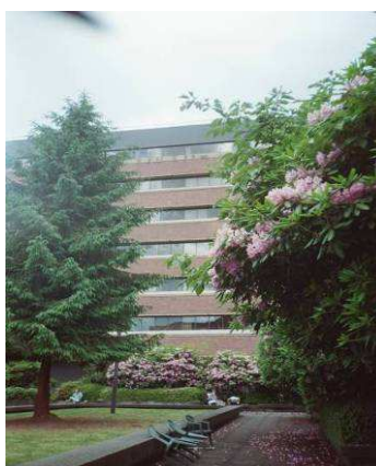
Figura 100: 4.o pavimento com central de ar condicionado e jardim
