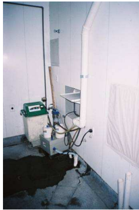
Caixa separadora da prata, dentro da câmara escura
