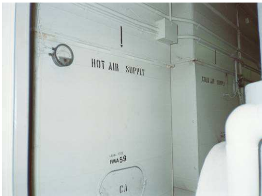
Figuras 117 e 118: Central de ar condicionado e de calefação
