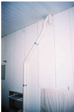
Exaustão da máquina e não da câmara escura
