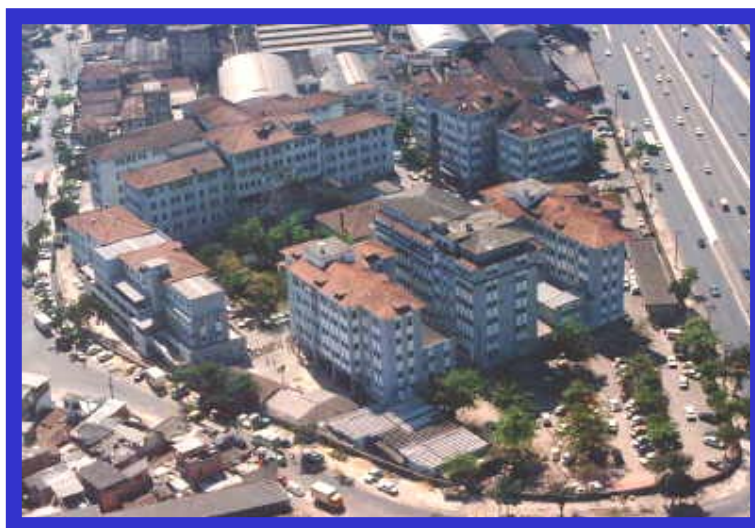
FIGURA 3.16 – Hospital Geral de Bonsucesso, de 1948
