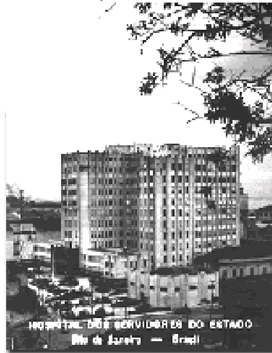
FIGURA 3.15 – Hospital dos Servidores do Estado
