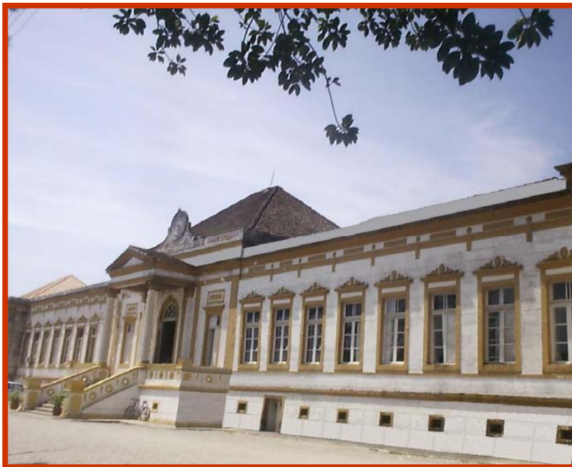
FIGURA 3.8 – Santa Casa de Misericórdia de São Francisco do Sul/SC, de 1859
