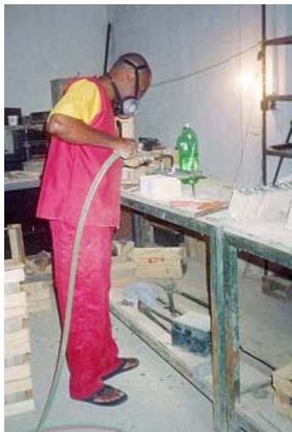
Figura 3.3 – Soldagem das placas de chumbo para instalação dos pinos.
