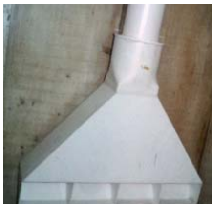
Figura 6.9 – Captor do tipo fenda (slot)
