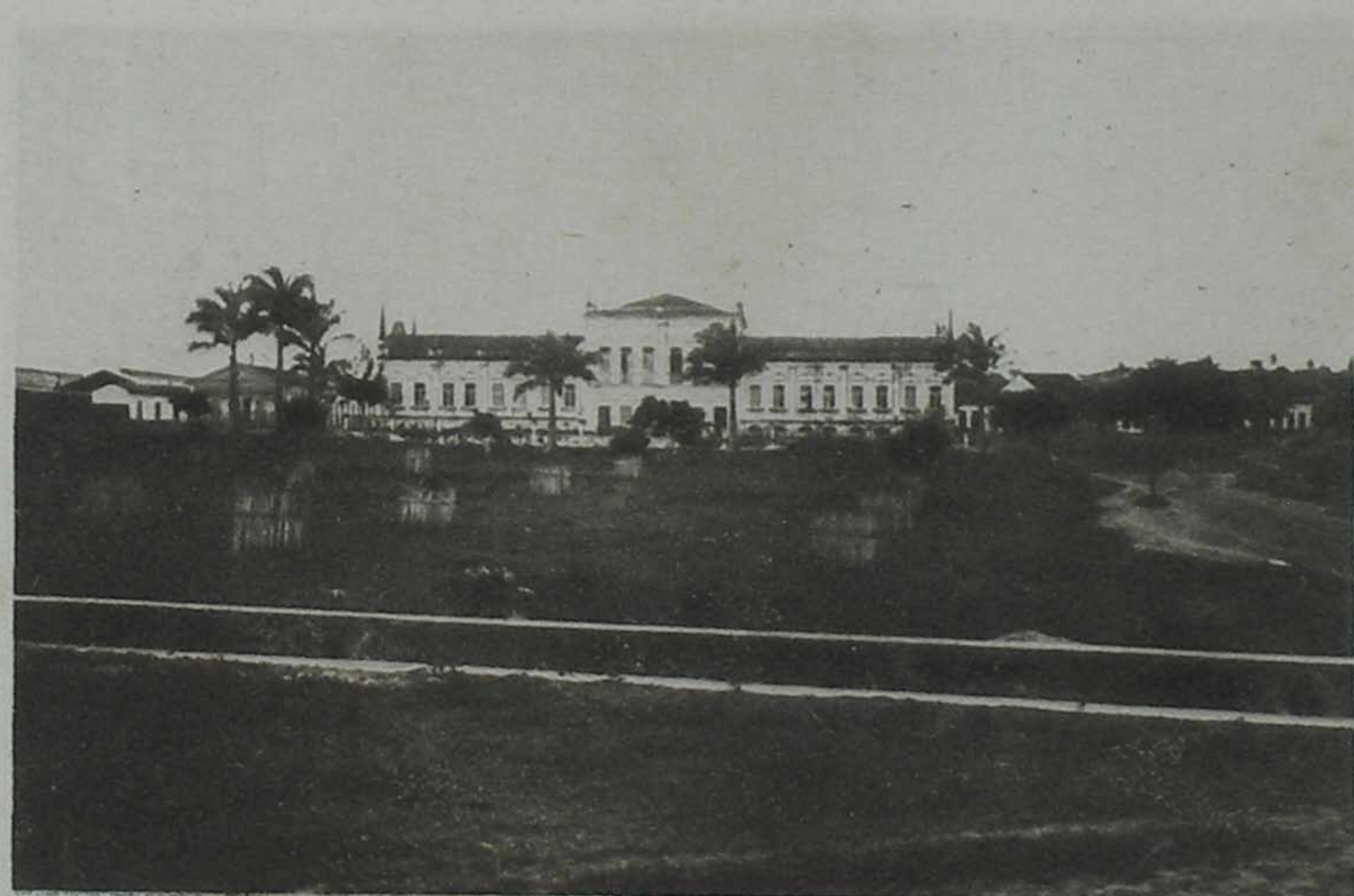
Camara Municipal da Cidade de Alagoinhas, no 1º plano ve-se o rio canalizado
