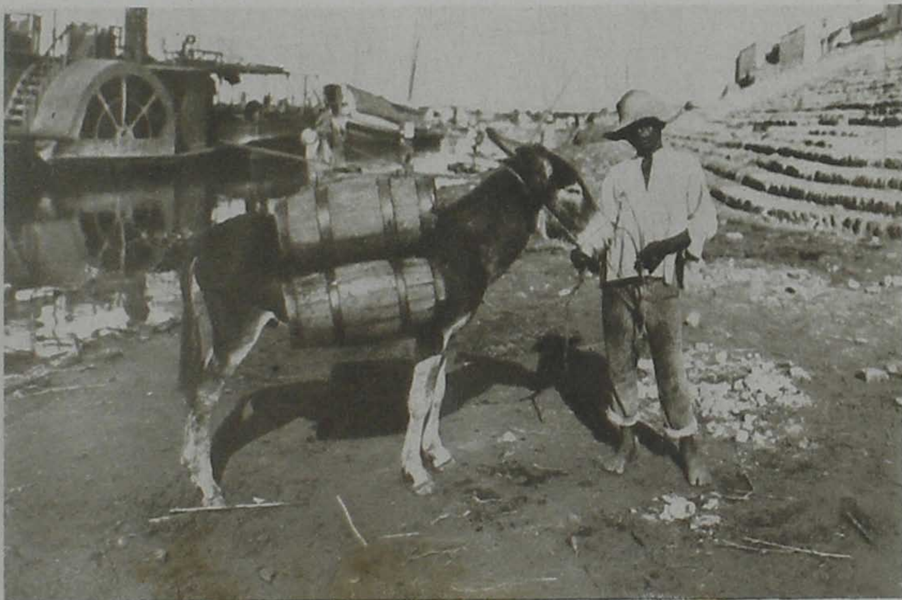
Processo de abastecimento dagua, na Cidade da Barra
