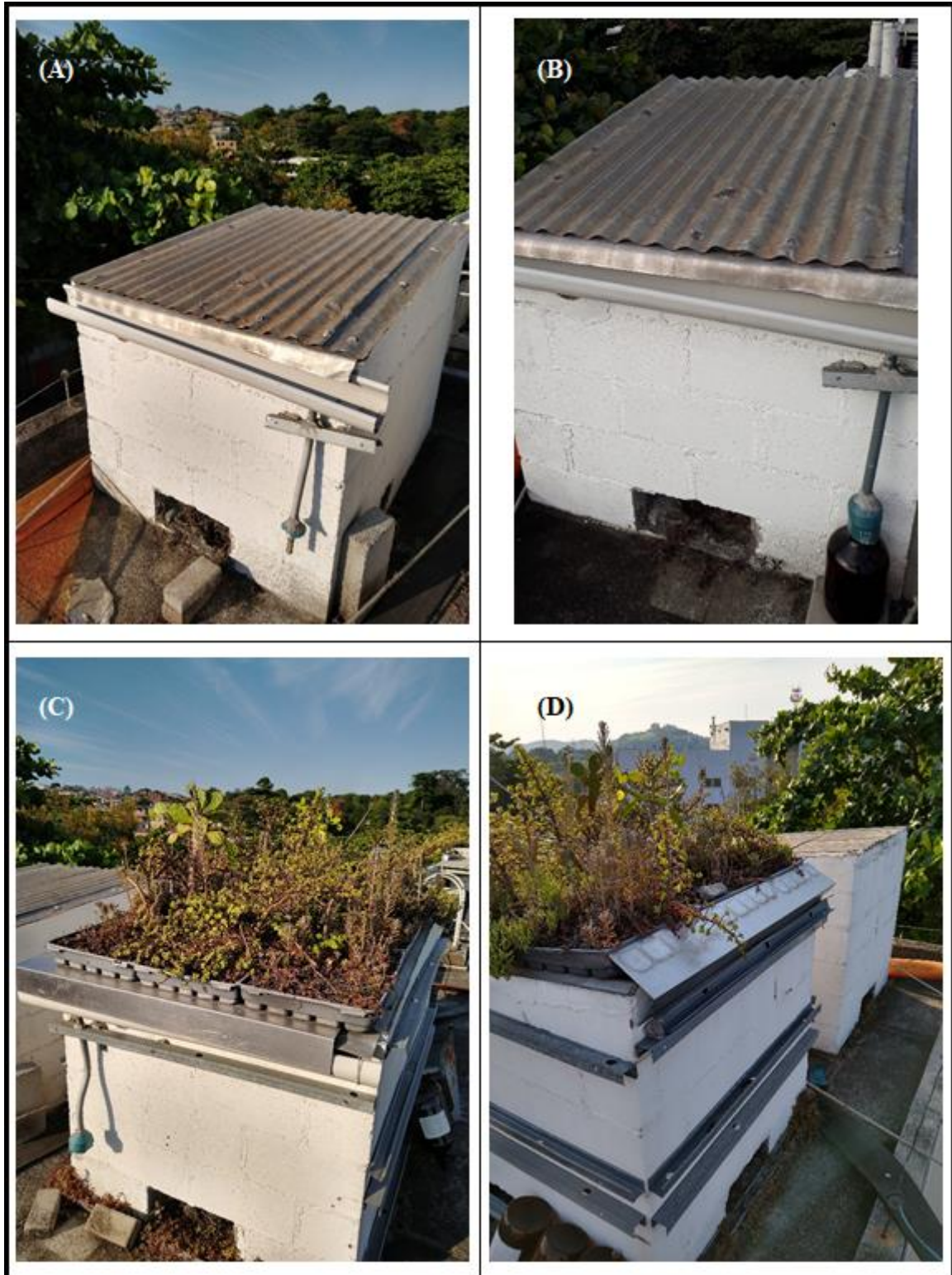
Figura 14 –Estruturas de alvenaria utilizadas para coleta das amostras das águas de chuva. O detalhe do telhado sem vegetação e a calha com o frasco para a coleta da água em (A) e (B), respectivamente. Em (C) e (D) mostra o telhado com os módulos vegetados. Detalhe para a cobertura da calha para impedir que a água captada pela percolação da camada vegetada seja contaminada por substâncias presentes na atmosfera.
