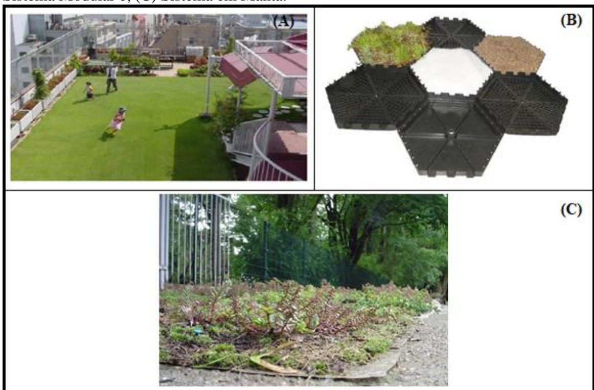
Figura 10 – Tipos de constituição dos telhados verde. Em (A) Sistema Completo; (B) Sistema Modular e; (C) Sistema em Manta.
