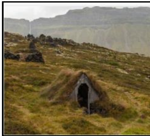
Figura 7– Primeiras coberturas vegetadas
