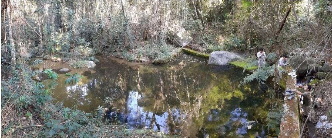
Figura 6 - Represa para captação de água.
