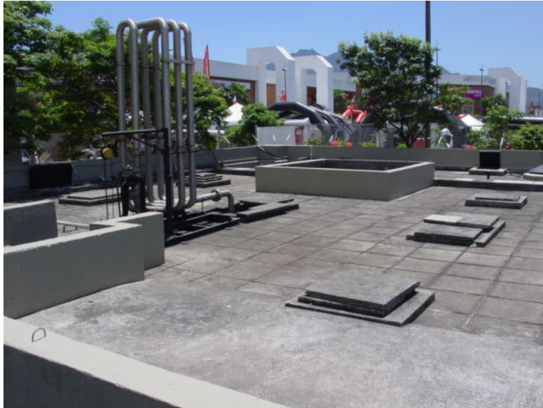
Figura 4.1 - Estação de tratamento de esgotos do empreendimento A.
