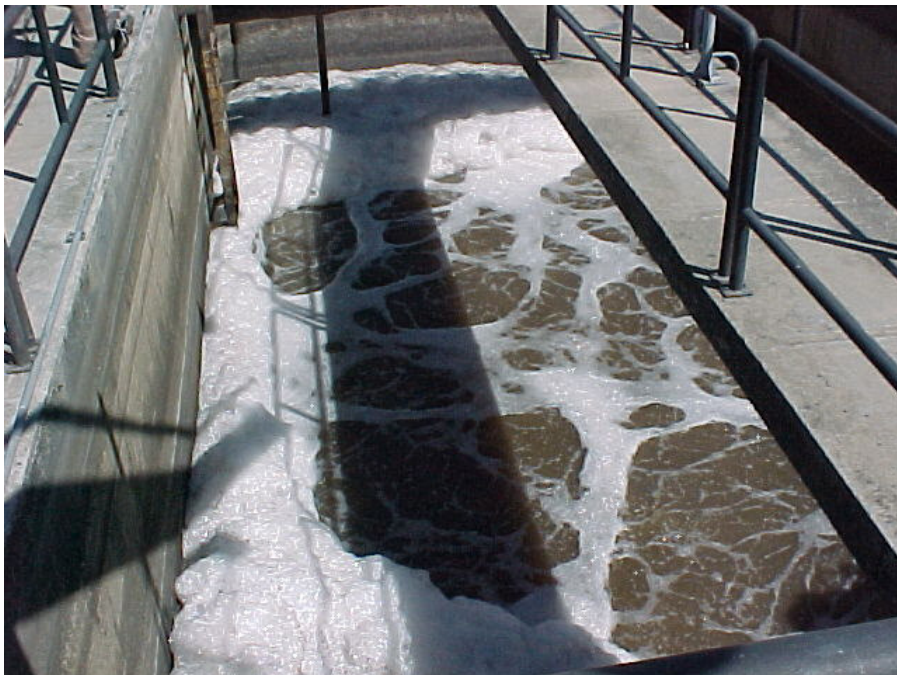
Figura 4.6 - Tanque de digestão de lodo da estação do empreendimento C.
