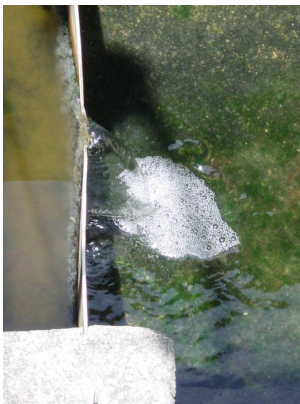
Figura 4.4 - Saída do efluente tratado da estação do empreendimento A.
