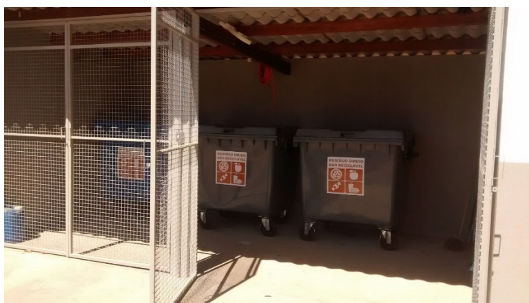
Figura 10 - Abrigo para resíduos sólidos finalizado; containers cedidos pelo DGA/UFMG Fonte: Arquivo da autora, 2019.
