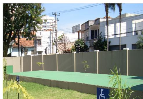
**Figura 9.** Filtros Anaeróbios
