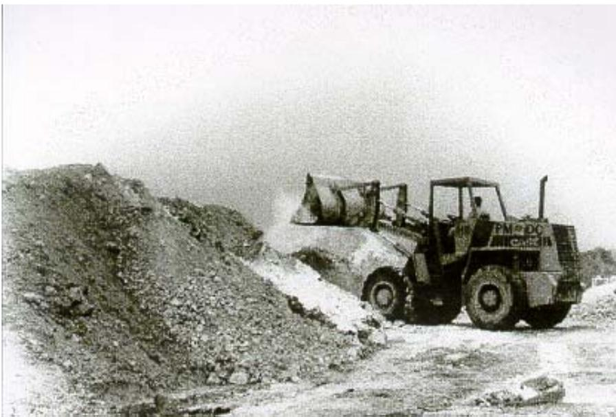
Figura 5.2 – Pá mecânica executando a mistura de cal virgem aos resíduos de HCH. (Fonte: Ermel, 1997)
