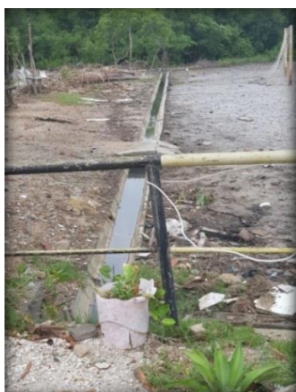
Figura 49: Valas ou canaletas abertas usados no escoamento do esgoto para o mangue ao lado do campo de futebol.
