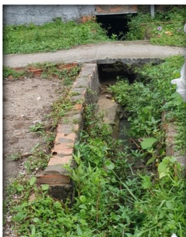
Figuras 51 e 52: Abertura comumente encontrada nas residências para escoamento do esgoto pelas valas ou canaletas a céu aberto seguindo até o mangue ou o mar. Fonte: Fotos tiradas pela autora, 2019.
