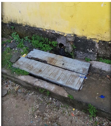
Figuras 53 e 54: Fossas rudimentares ao lado e na frente das residências. Fonte: Fotos tiradas pela autora, 2019.
