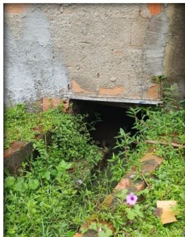
Figuras 51 e 52: Abertura comumente encontrada nas residências para escoamento do esgoto pelas valas ou canaletas a céu aberto seguindo até o mangue ou o mar. Fonte: Fotos tiradas pela autora, 2019.
